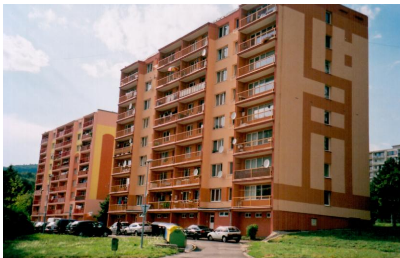
Obr. 14: Regenerované panelové domy v Kopitské ulici.
