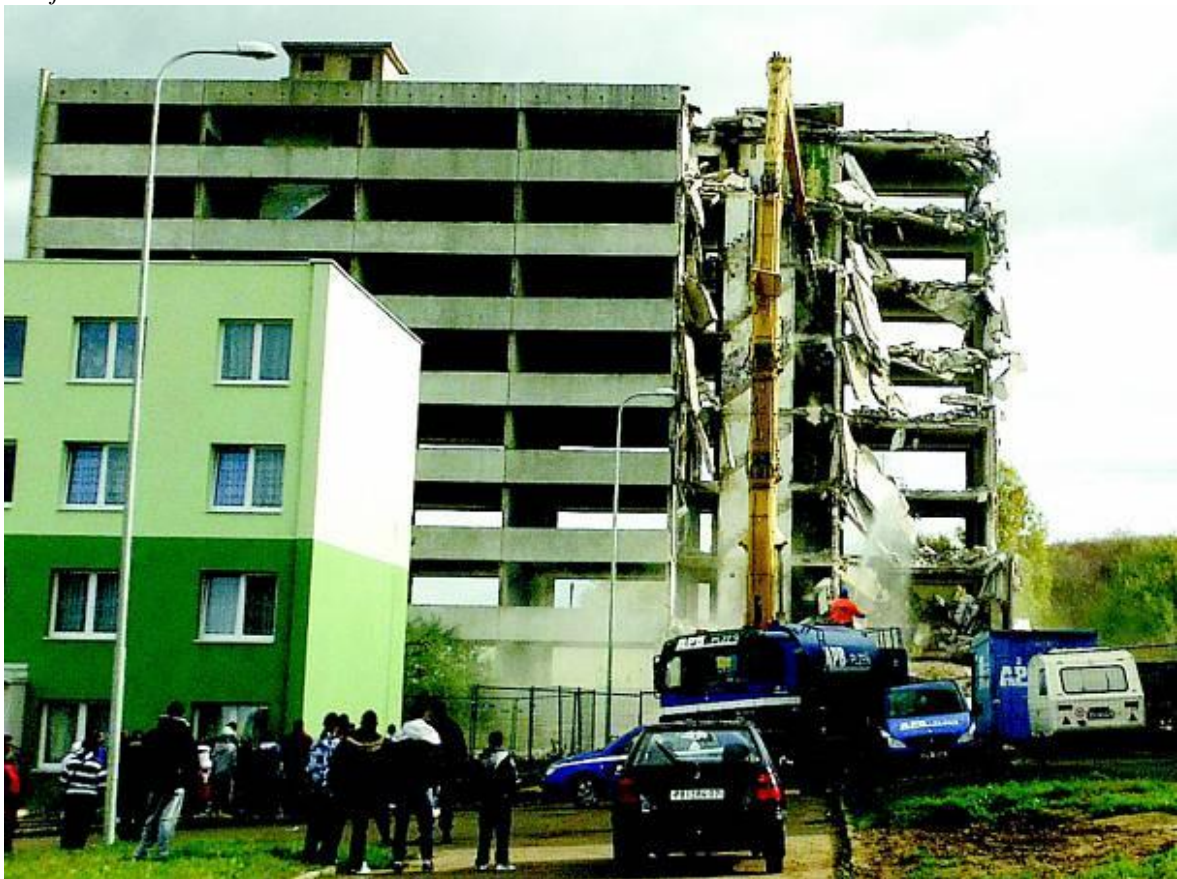
Obr. 69: Bourání panelového domu v ulici Kovářská (říjen 2013). Zdroj: Milan Nebesář.
