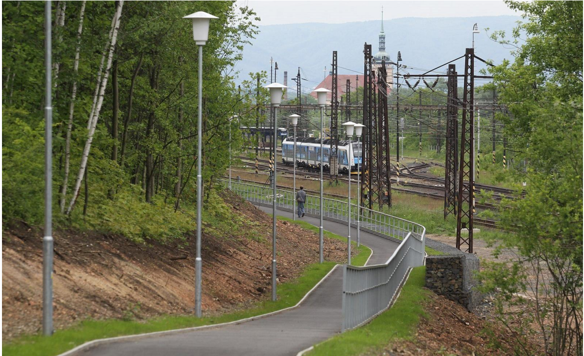
Obr. 71: Nový chodník z Chanova do Mostu. Zdroj: Iveta Lhotská
