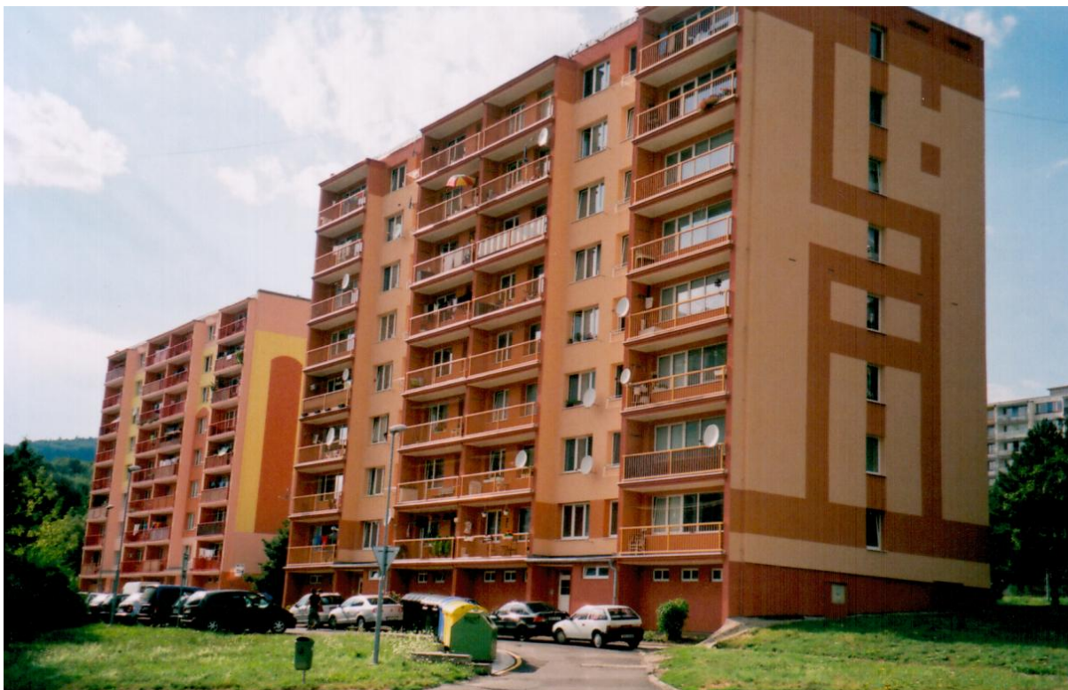
Obr. 60: Regenerované panelové domy v Kopistské ulici.
