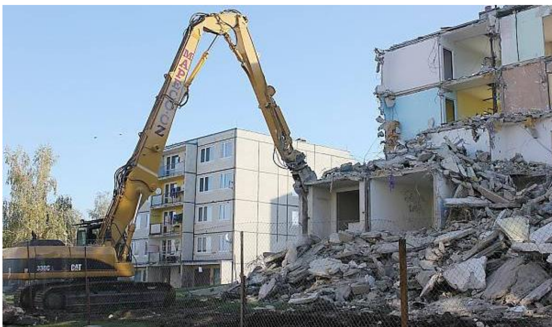
Obr. 33 – Demolice obytného objektu v Bečově (okres Most).
