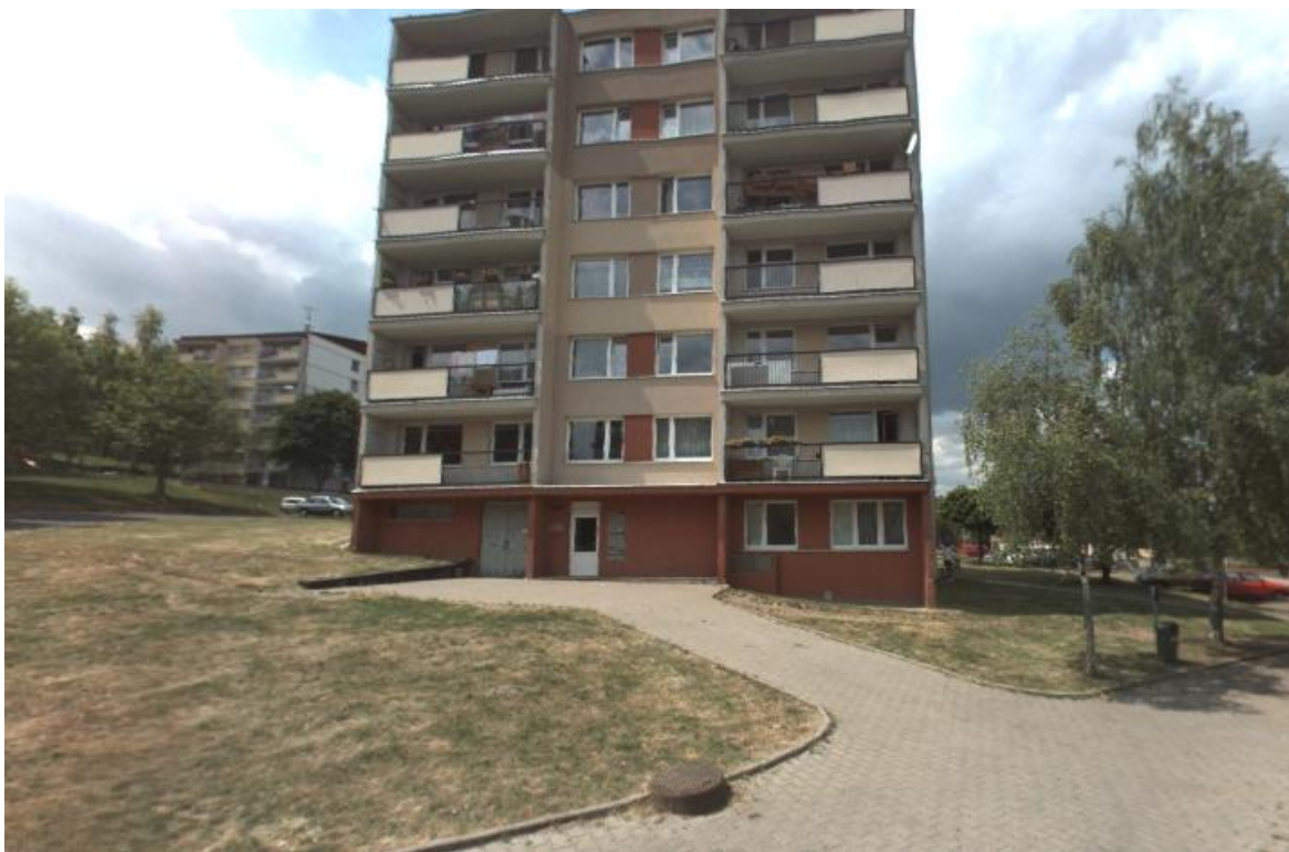
Obr. 80: Opravený bytový dům a revitalizované povrchy komunikací v lokalitě Velké sídliště. Zdroj: V.T. Zoubková (2014).
