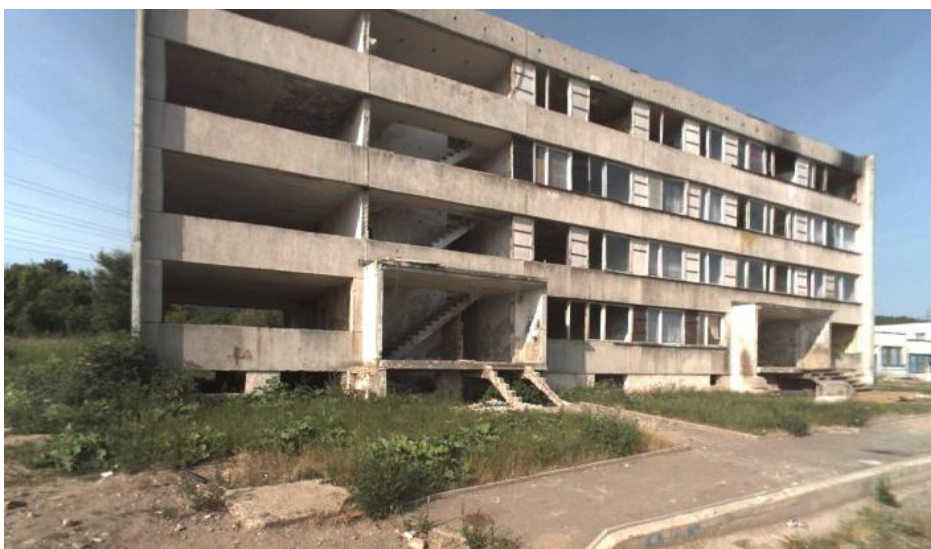
Obr. 73: Železná č. p. 204-205 (blok 1) v roce 2014. Zdroj: V.T. Zoubková.
