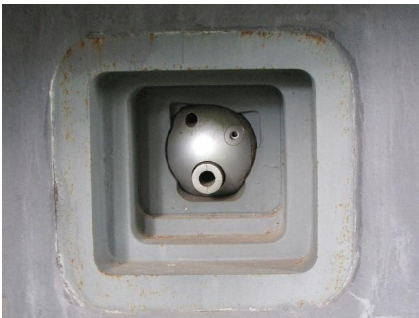
Obr. 103 – pupila záměrného dalekohledu vz. 36, hlaveň těžkého kulometu vz. 37 a protitankového kanonu vz. 36 v těsnící kouli zbraně L1 ve střílně hlavních zbraní, muzeum čs. opevnění KS – 5 „U potoka“, současný stav, archiv J. Hrubeckého
