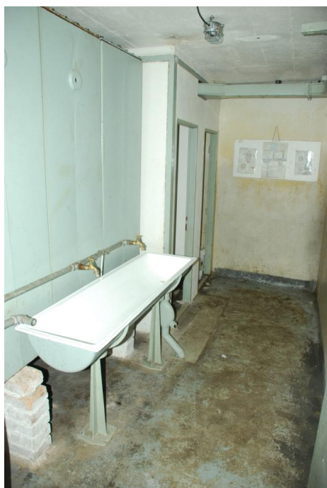
Obr. 120 – umývárna se žlabem a splachovací toalety pěchotního srubu, muzeum KS – 5, současný stav, archiv J. Hrubeckého
