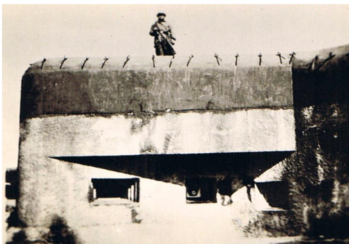
Obr. 90 – jedním z nejdůležitějších a ustavičně vykonávaných úkolů hraničářů bylo střežení pevnostních objektů. Zde strážný na stropě objektu RS – 74, ve střílně dobře patrná hlaveň zbraně L1, 1938, archiv J. Hrubeckého
