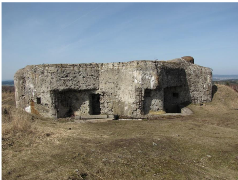
Obr. 28 – cvičný objekt CE na cílové ploše Jordán, bývalý VVP Brdy, dějiště KPZÚ, současný stav (březen 2016), archiv J. Hrubeckého
