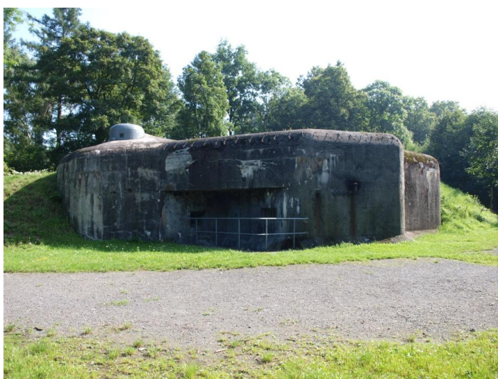
Obr. 62 – pěchotní srub MO – S 18 „Obora“, ve kterém sloužil rotný Jaroslav Švarc, současný stav, areál čs. opevnění Darkovičky, archiv J. Hrubeckého
