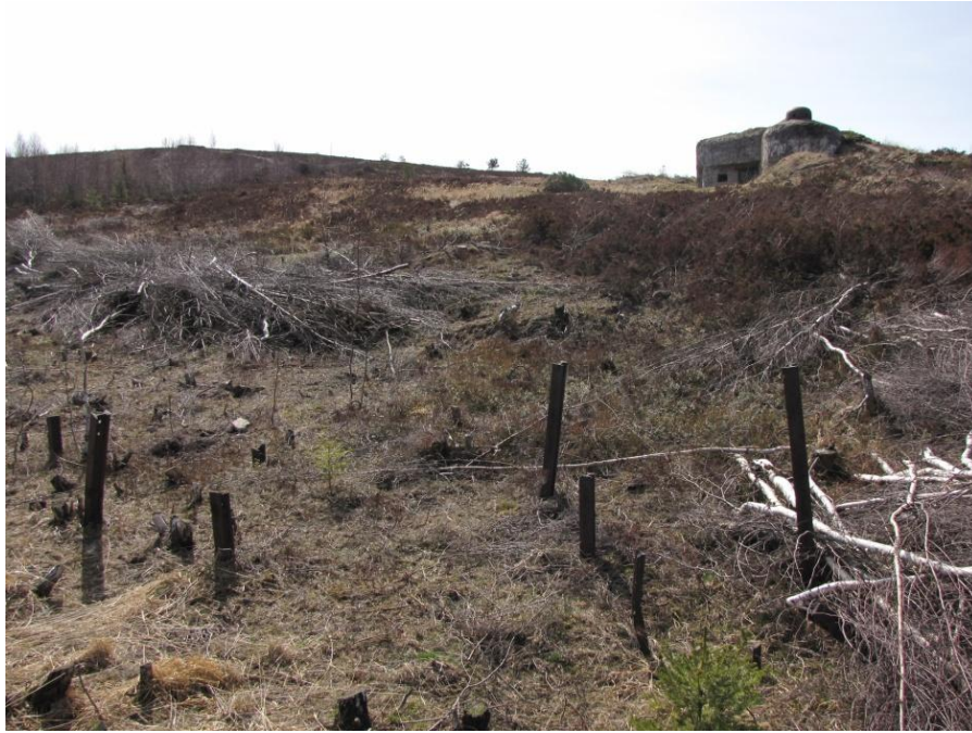
Obr. 32 – pohled na objekt CE přes dochované pozůstatky testované obvodové překážky, v popředí tzv. zvláštní zařízení pro přehrazení komunikací, archiv J. Hrubického
