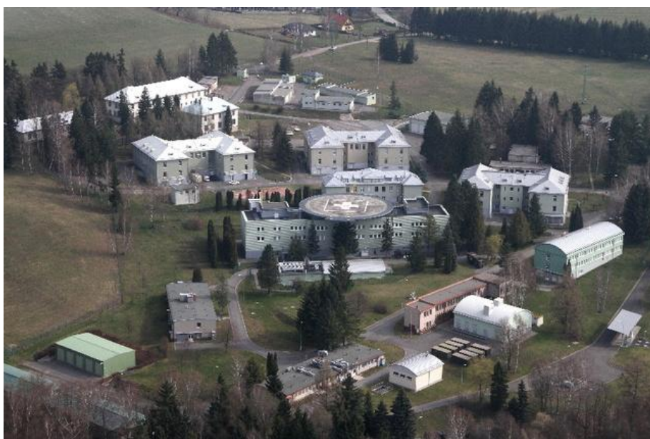
Obr. 98 - kasárna HP 19 v Těchoníně, dnes středisko bakteriologické ochrany AČR, současný stav, archiv J. Hrubeckého
