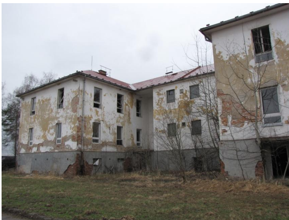
Obr. 96 – kasárna HP 19 pro tvrz Hanička v Rokytnici v Orlických horách, současný stav (březen 2014), archiv J. Hrubeckého
