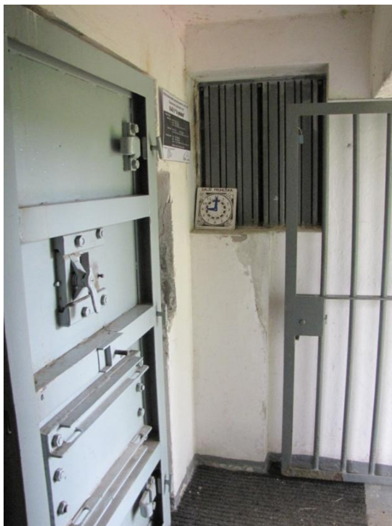
Obr. 107 – vchod do pečotního srubu jištěný mříží, prvními pancéřovými dveřmi o hmotnosti 250 kg s nouzovým výlezem a vchodovou střílnou. Ve stěně patrný nasávací otvor vzduchu pro filtronu objektu, muzeum čs. opevnění KS – 5, současný stav, archiv J. Hrubeckého
