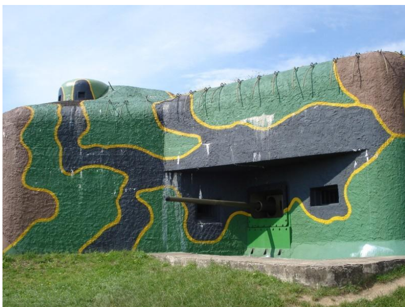
Obr. 124 – detail kanonu PvK. vz. 44 ráže 85 mm ve srubu MJ – S 3, archiv J. Hrubeckého
