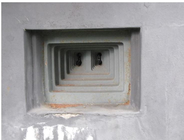
Obr. 104 – dvojče TK vz. 37 ve střílně hlavních zbraní, muzeum čs. opevnění KS – 5, současný stav, archiv J. Hrubeckého
