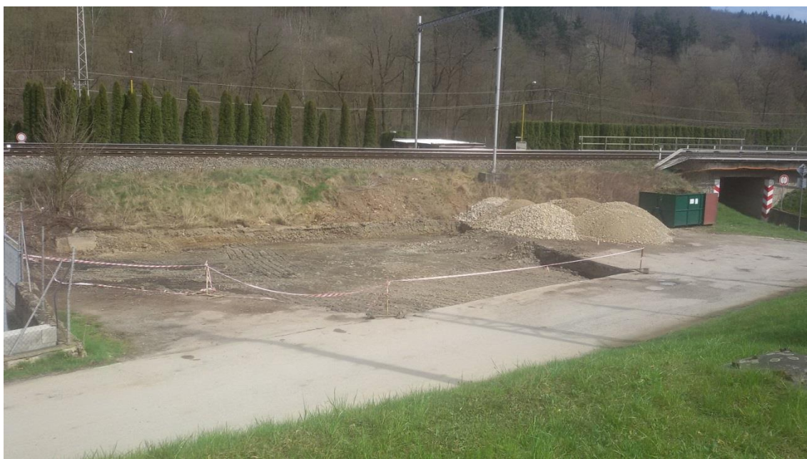
Fotografie 22: Nově budovaná mezideponie BRO na Kolonci
