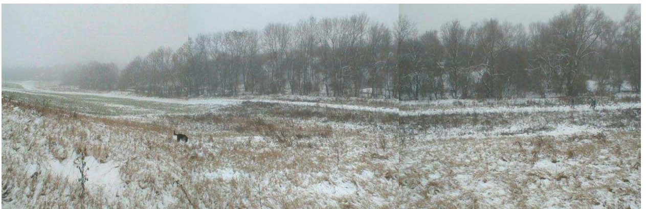
Foto č. 3 – pohled na místo výstavby hráze suché nádrže (zima 2002)
