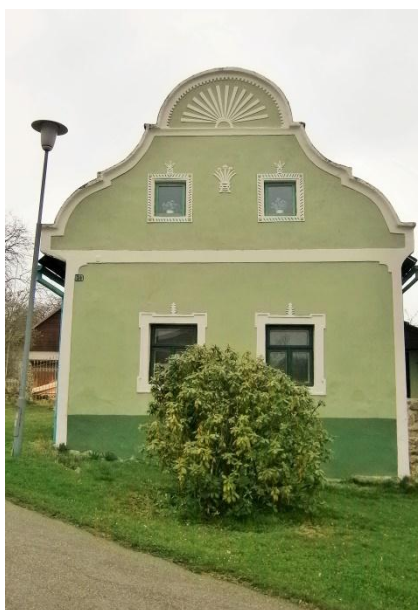
Obr. č. 35 Obytné stavení čp. 34
