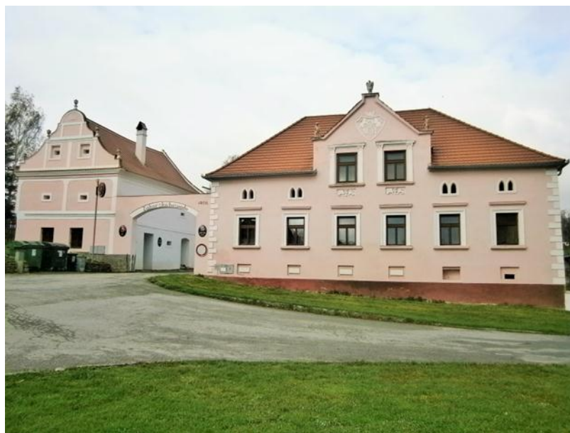
Obr. č. 15 Usedlost čp. 15, po levé straně průčelí stojí patrová sýpka
