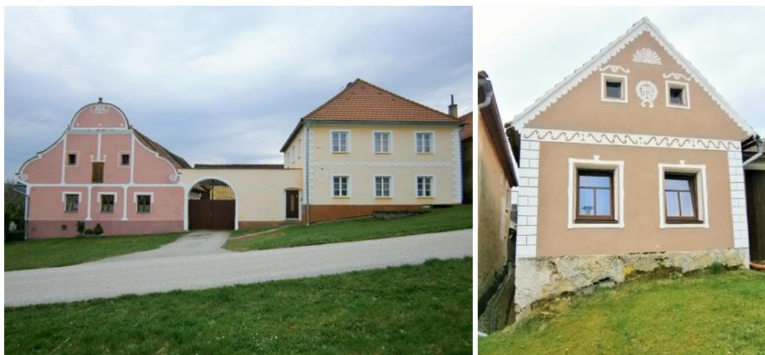
Obr. č. 32 Průčelí usedlosti čp. 30 a 5; obr. č. 33 Výměnek čp. 31
