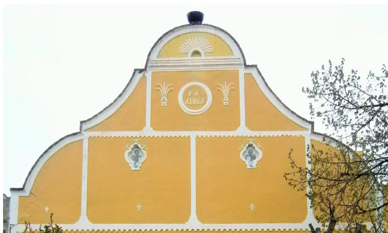
Obr. č. 26 Typické prvky domovních štítů – dům čp. 32
