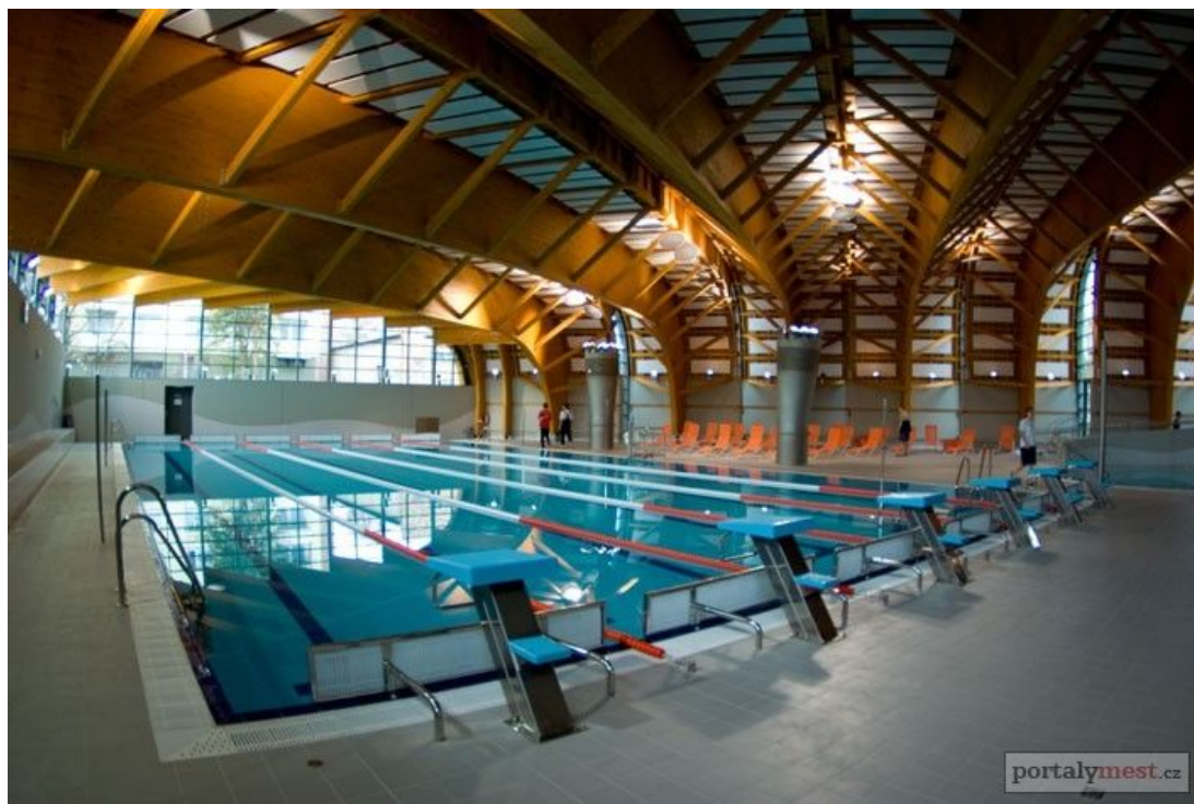
Obrázek 16 - Aquapark Kohoutovice pohled na 25m bazén, zdroj[16]
