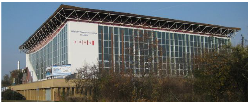
Obrázek 12 - Pohled na budovu městského plaveckého stadionu z ulice Sportovní, zdroj [8]
