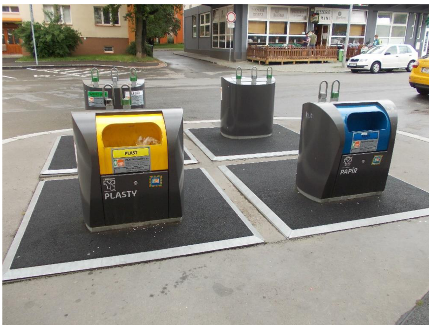
Obr. 7: Podzemní kontejnery na separovaný odpad [18]
