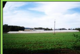
Stávající areál firmy ECO Finance Group s.r.o.
