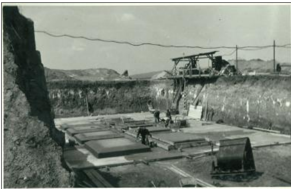
Obr. 51: Budování vodojemu na Stráži – 11.5 1950, I. nádrž – betonový podklad dna (externí materiál Veolia, 2013)
