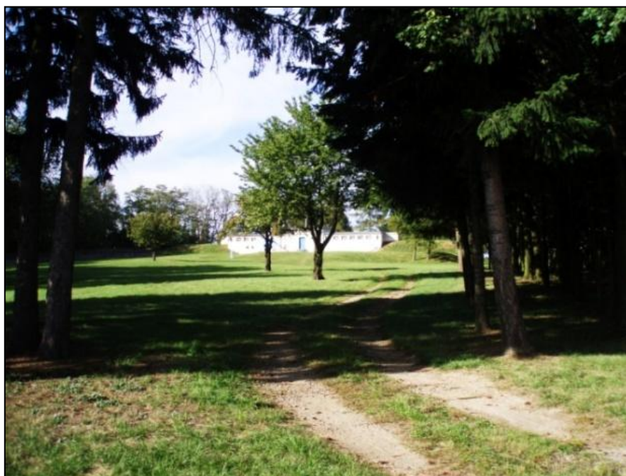
Obr. 49: Pohled do areálu vodojemu, počátek září 2012 (BORECKÁ, 2012)
