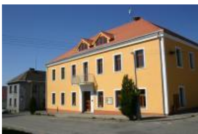
Zrekonstruovaná budova školy 17 OÚ 18
