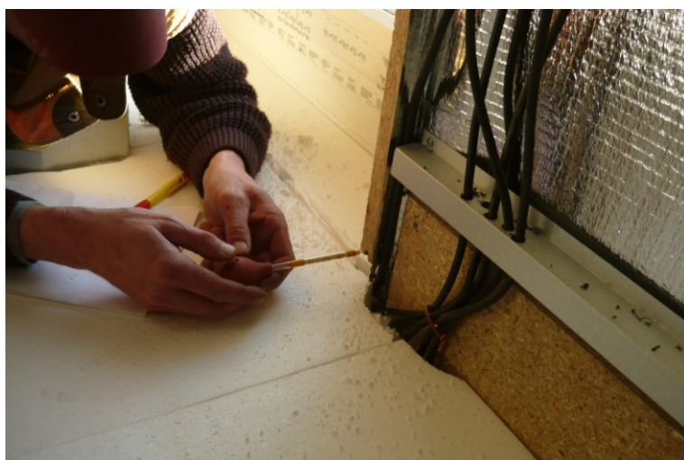
Obr. 5 Měření choulostivých míst – průchod u elektroinstalace.
