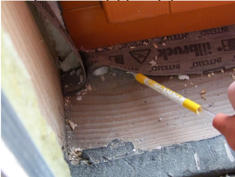
Obr. 6 Zjišťování úniků u připojovací spáry oken
