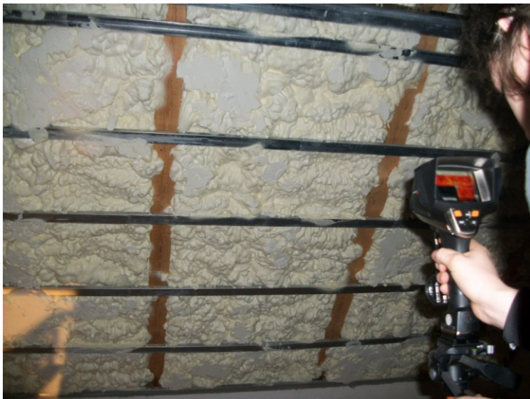
Obr. 3 Měření teploty povrchu pomocí termokamery
