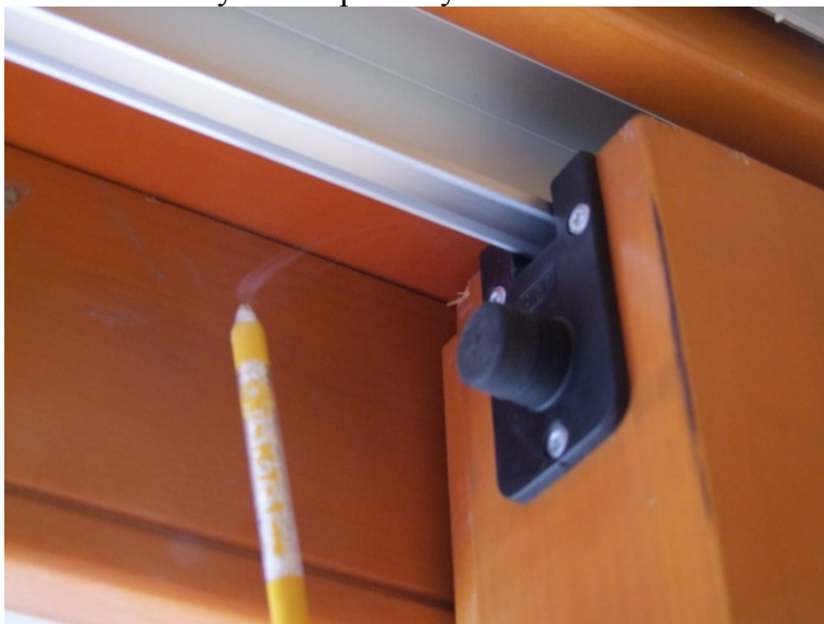
Obr. 2 Viditelný únik u posuvných dveří
