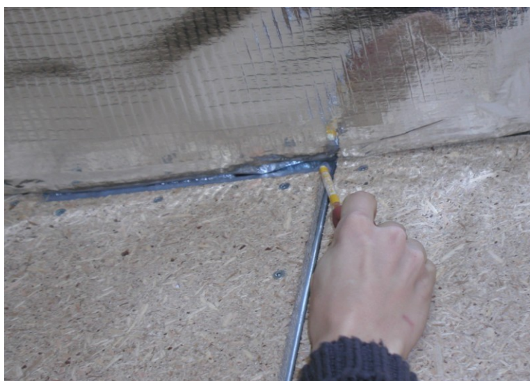
Obr.7 Zjišťování průvzdušnosti v rohovém spojení stěnového a stropního systému.
