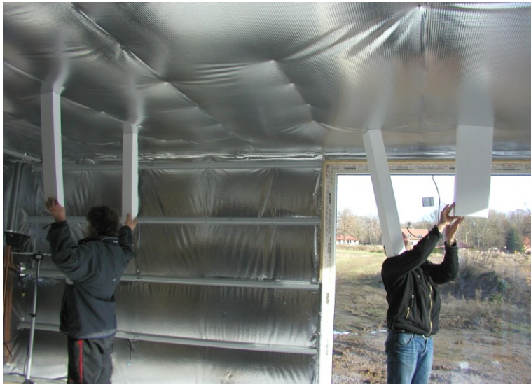
Obr.10 Jištění parotěsné fólie při provádění testu – podtlak.
