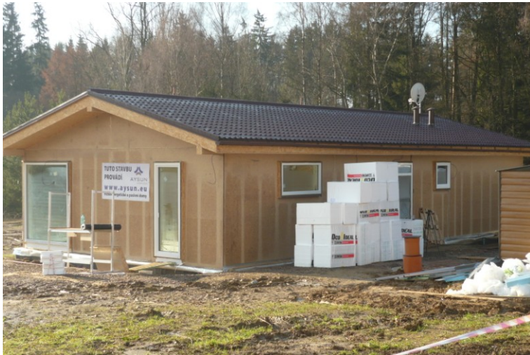
Obr. 2 SV pohled, polystyrén připravený pro vnější fasádu.
