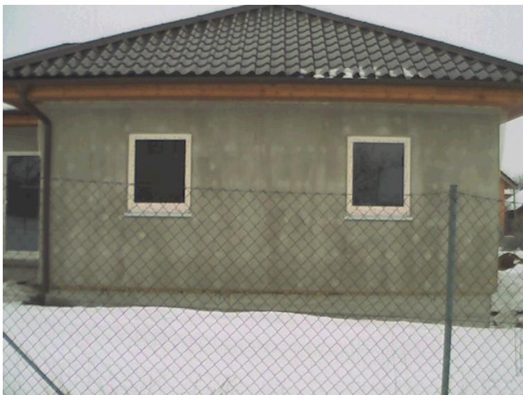
Obr. 2 Západní pohled na objekt
