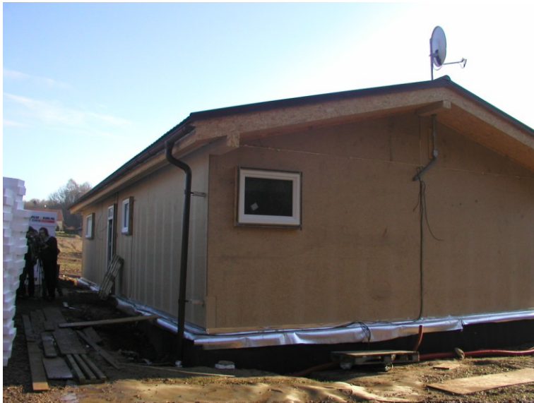
Obr. 3 Z pohled ukazuje velmi malou plochou otvorových výplní.
