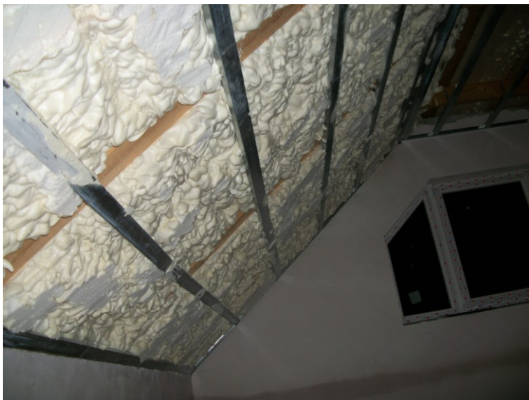
Obr. 2 Detailnější pohled na pěnovou izolaci
