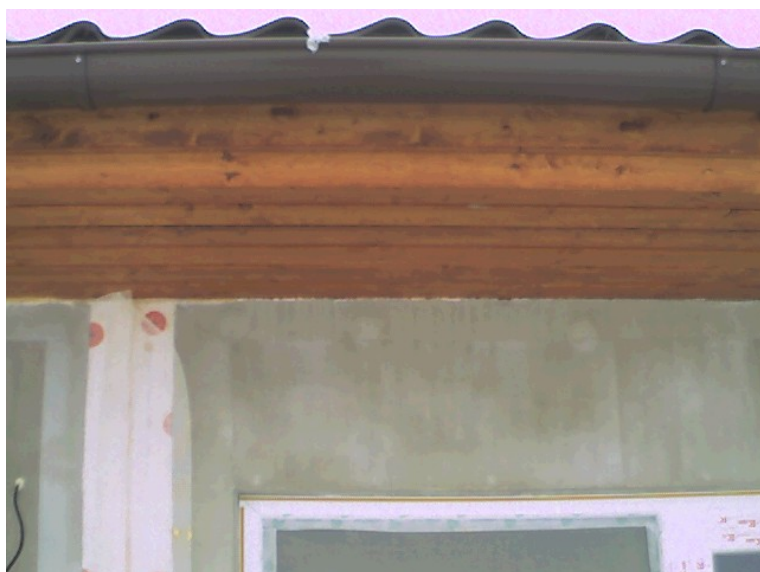
Obr. 3 Detail provedení podhledů
