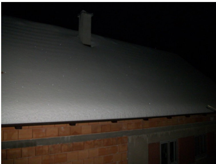
Obr. 4 Vnější pohled na měřenou střešní konstrukci
