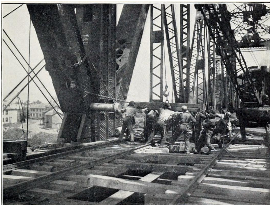
Obr. 3: Čepování mostní příhradové konstrukce Monaca-Beaver v Pittsburghu, které bylo nafoceno roku 1911 [46].
