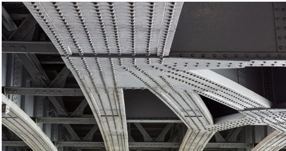
Obr. 7: Nýtovaný most v ulici Hybešova v Brně, jehož styčníky jsou realizované pomocí styčnickových plechů [83].
