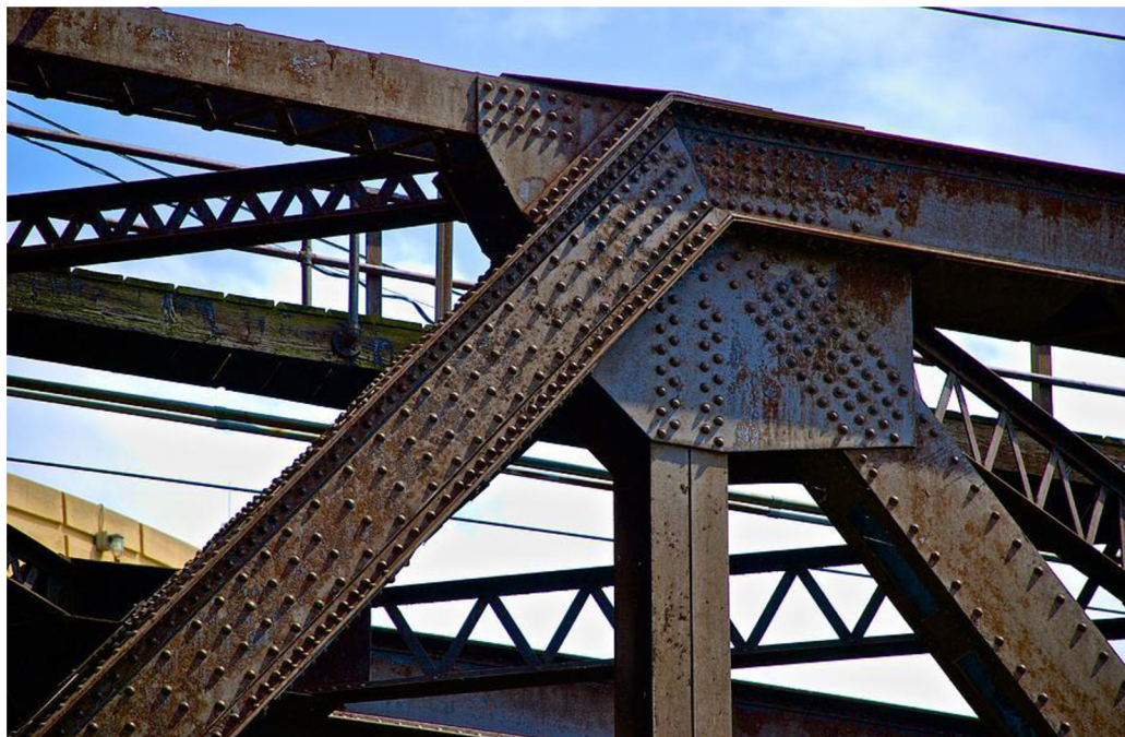
Obr. 4: Styčnickový plech připojený pomocí nýtů na Dundee Railroad bridge v Dundee Monroe v Michiganu [16].
