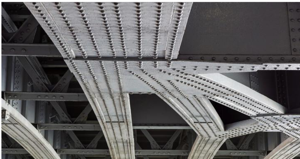
Obr. 7: Nýtovaný most v ulici Hybešova v Brně, jehož styčníky jsou realizované pomocí styčnickových plechů [83].
