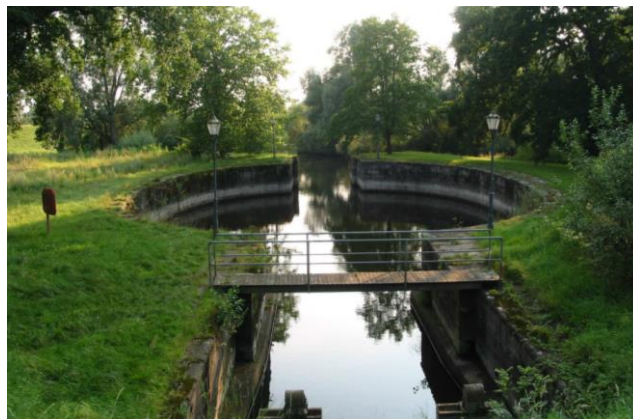
Obrázek č. 22: Bývalá plavební komora na Labi na území Německa v areálu restaurace (Zdroj: 4)
