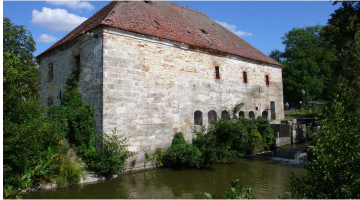
Obrázek č. 21: Mlýn na Sánské strouze v obci Pátek na Nymbursku (Zdroj: 4)
