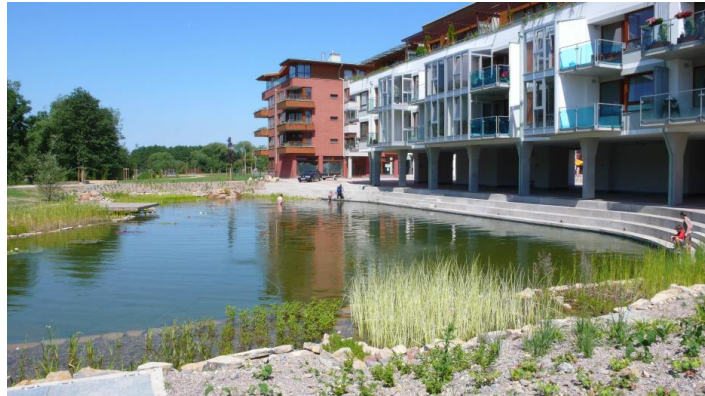
Obrázek č. 20: Dům na vodě v Dolních Břežanech (Zdroj: 4)
