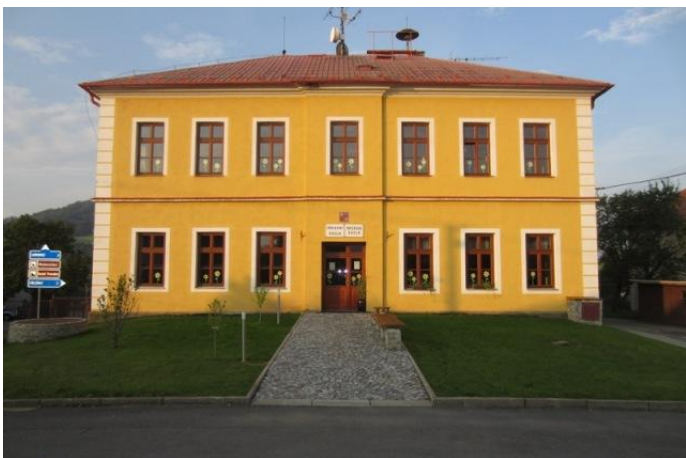
Základní škola v obci Provodov ( http://skola.provodov.cz/ )
