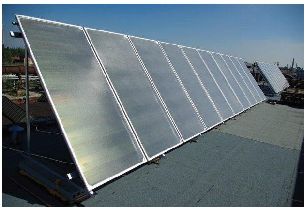
Obrázek 4 Sluneční kolektorový systém pro ohřev vody
