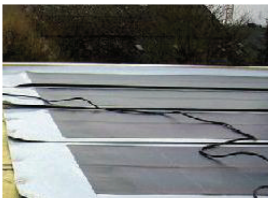
Obrázek 11 Ukázka použití solární fólie s amorfnními články. [8]
