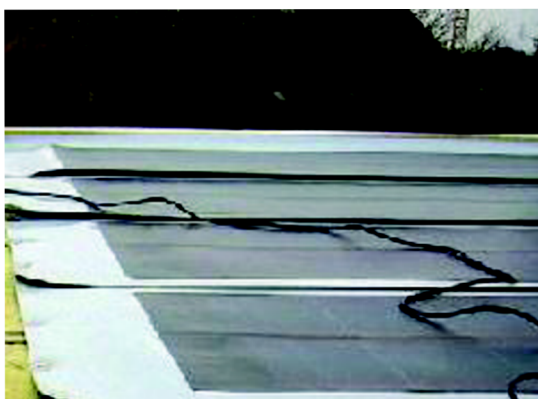
Obrázek 11 Ukázka použití solární fólie s amorfnními články. [8]
