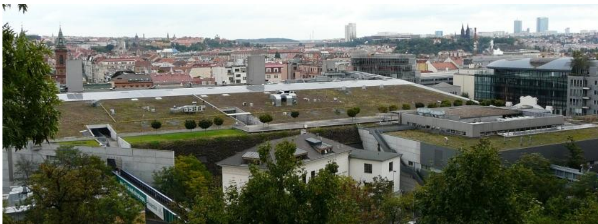
Obr. č. 19 - Kombinace extenzivní a intenzivní střešní zahrady, OC Nový Smíchov, Praha, září 2015
