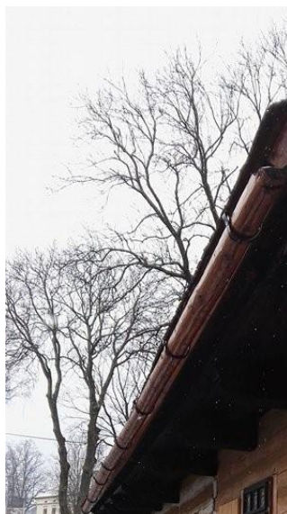
Obrázek č.32 – detail dřevěného okapu (Pipková, 2018)
