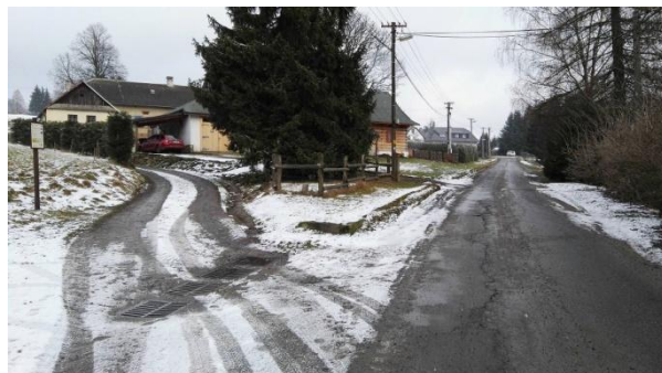
Obrázek č.36 – původní hlavní komunikace (vlevo) (Pipková, 2018)
