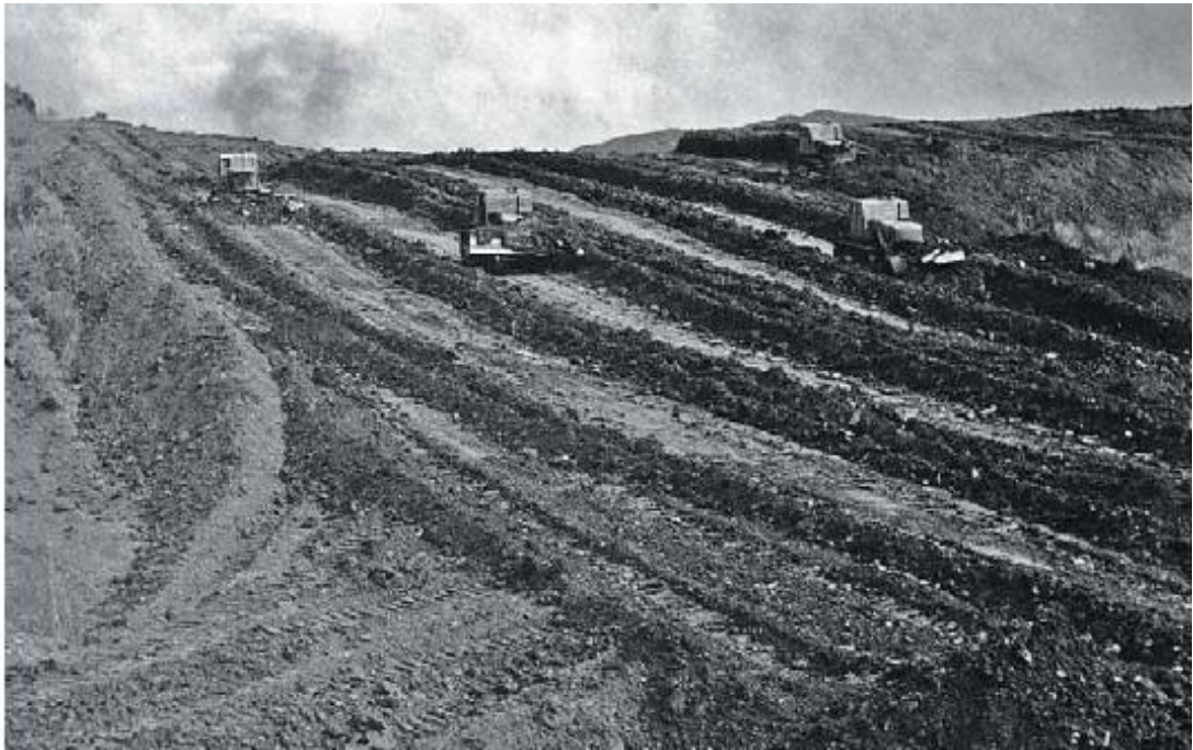
Obrázek 20: Úprava jižních svahů výsypky lomu Merkur nedaleko Kadaně, snímek z roku 1974 (Štýs, 2014).
