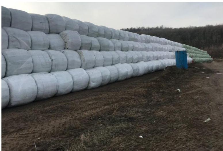
Obrázek 5: Protihluková stěna v průběhu budování (H-Rekultivace, 2019).
