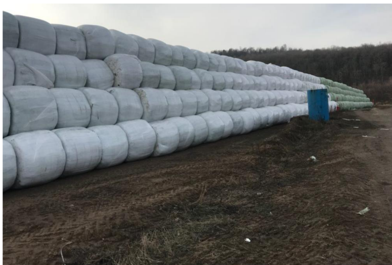
Obrázek 5: Protihluková stěna v průběhu budování (H-Rekultivace, 2019).
