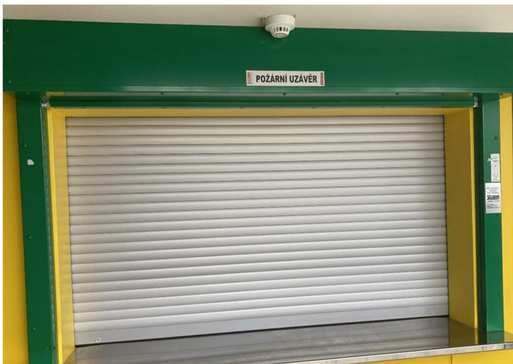
Obrázek 8 Požární roleta v bufetu [zdroj vlastní]
