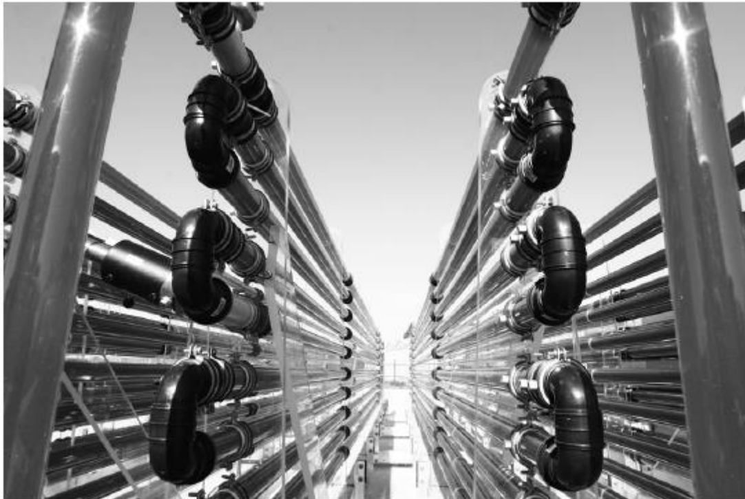
Obrázek 4: Vertikální trubicovitý fotobioreaktor [3]
