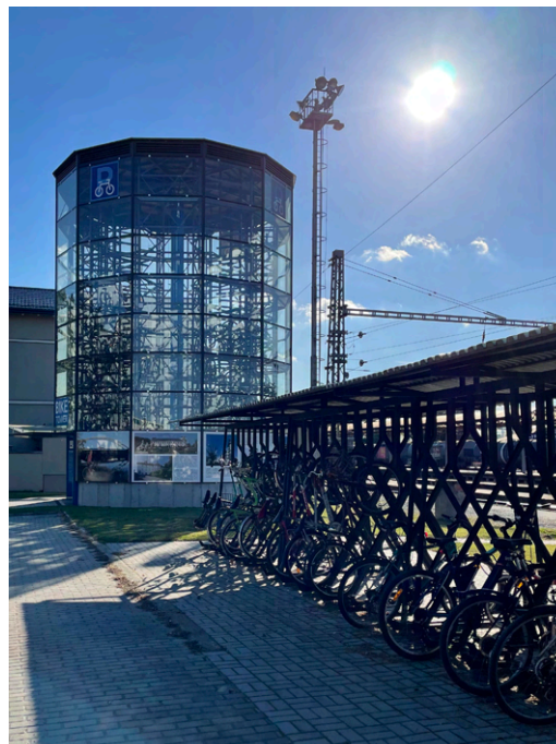
Obrázek č. 48: Příklad biketoweru a stojanu pro uložení jízdních kol v Lysé nad Labem (Autor práce, 2021)
