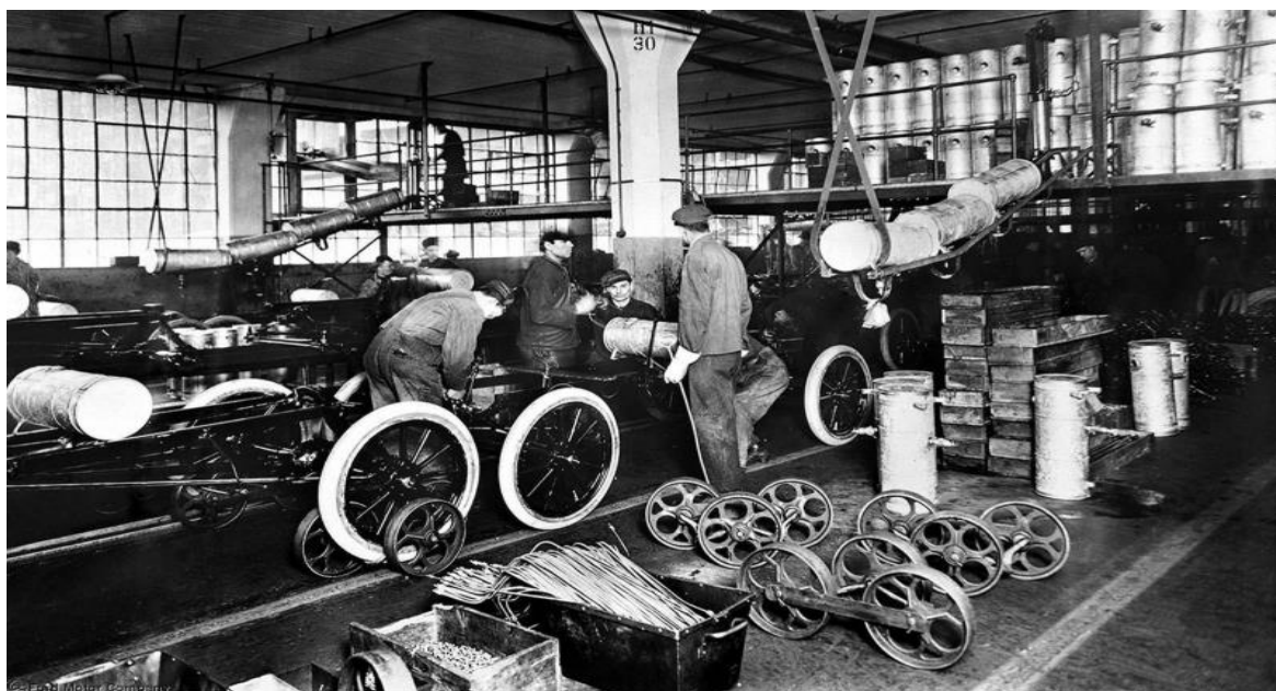
Obrázek 1 - První pohyblivá montážní linka Henryho Forda
