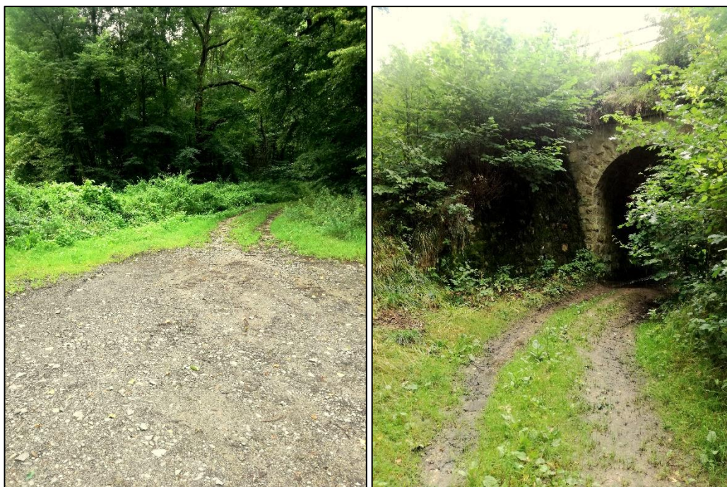
Obr. č. 24 Polní cesta DC5 s železničním viaduktem
