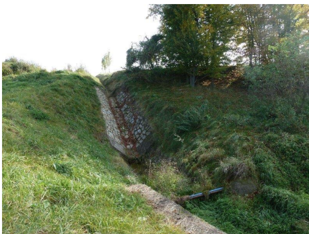
Obr. č. 7 Příkop svodný, v místě vyústění příkopu do poldru (Katalog SPÚ 2010)
