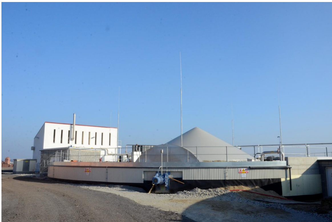
Obr. č. 1- Bioplynová stanice (foto autor)
