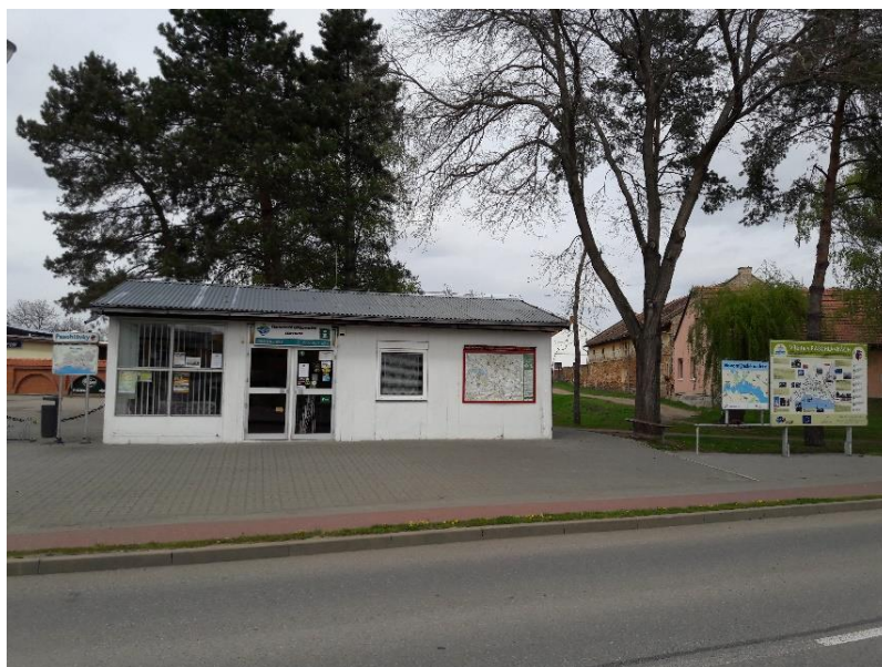
Obrázek č. 6 - Budova TIC Pasohlávky Zdroj: Vlastní fotografie.
