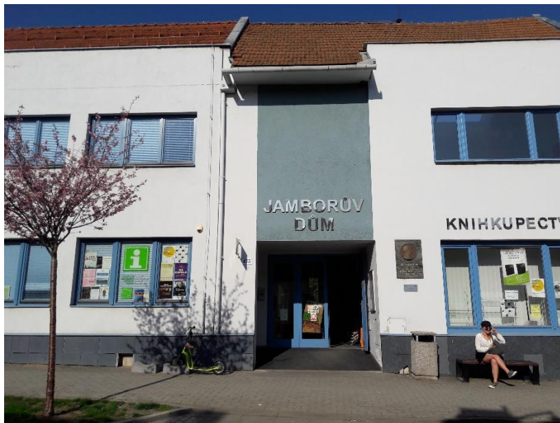
Obrázek č. 3 - Budova TIC Tišnov
