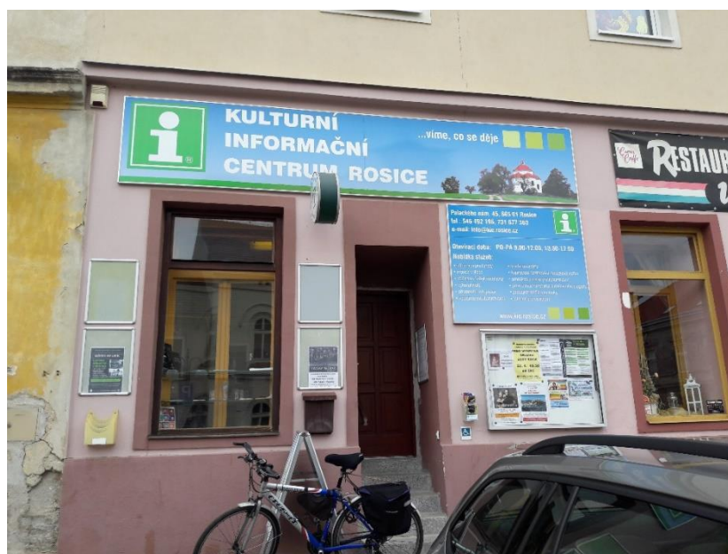
Obrázek č. 5 - Budova KIC Rosice
