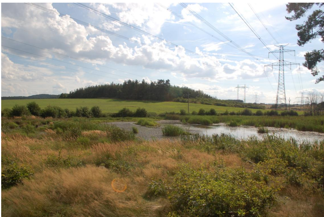
Příloha č. 8 - Jezero (N 49.6588218; E 49.6588218) – příklad srovnávací lokality k bývalému VVP Brdy (PP Jablonná – mokřad) (foto: Stanislav Švaček).
