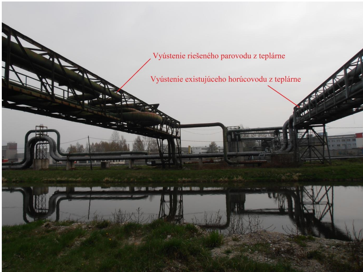
Obrázok 5- Začiatok potrubného distribučného systému
