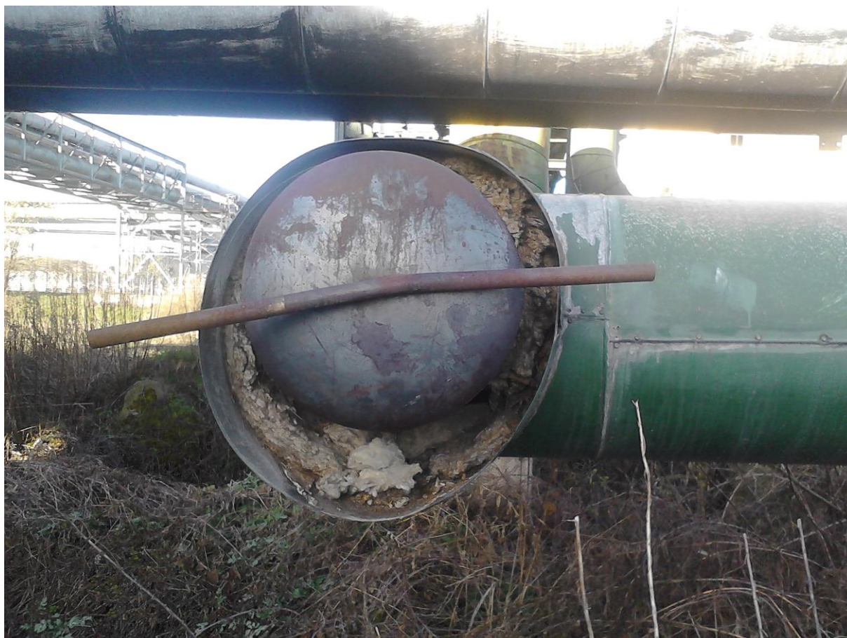
Obrázok 10- Stav izolácie v priereze parovodu
