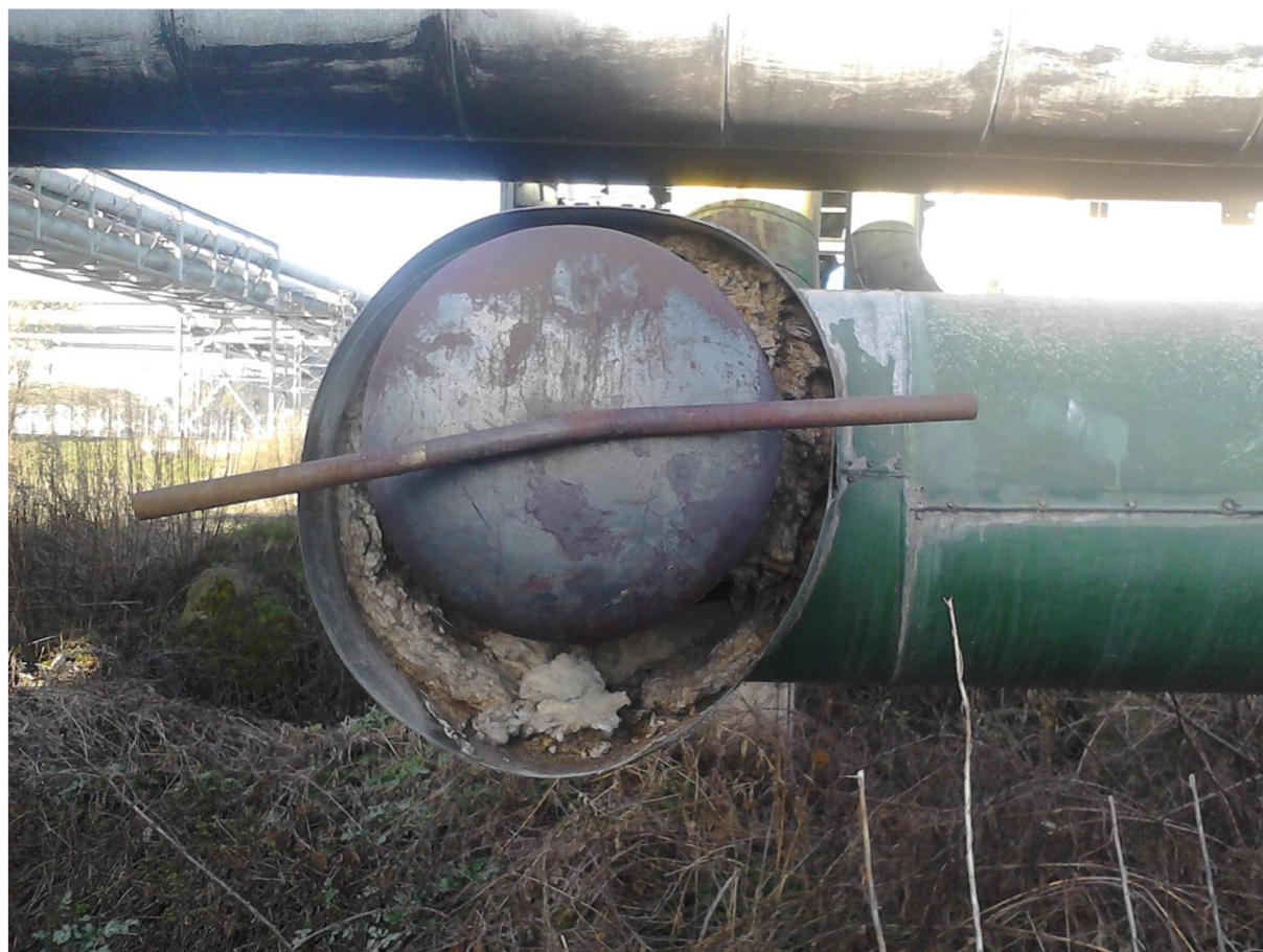
Obrázok 10- Stav izolácie v priereze parovodu
