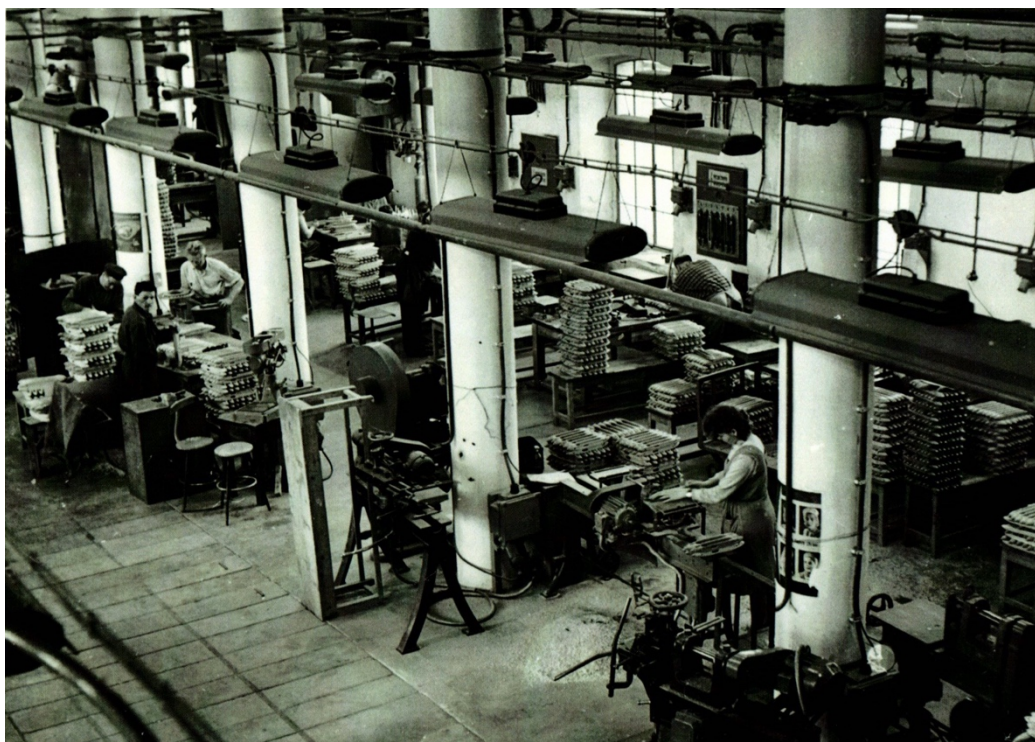
Obrázek 28: Prostory přízemního sálu budovy č. p. 212 v době, kdy v bývalé továrně vyráběly tkalcovské člunky, 70. léta 20. století (Zdroj: Soukromý archiv Dany Grabcové, Pavla Doležala a Jaroslava Kordíka)
