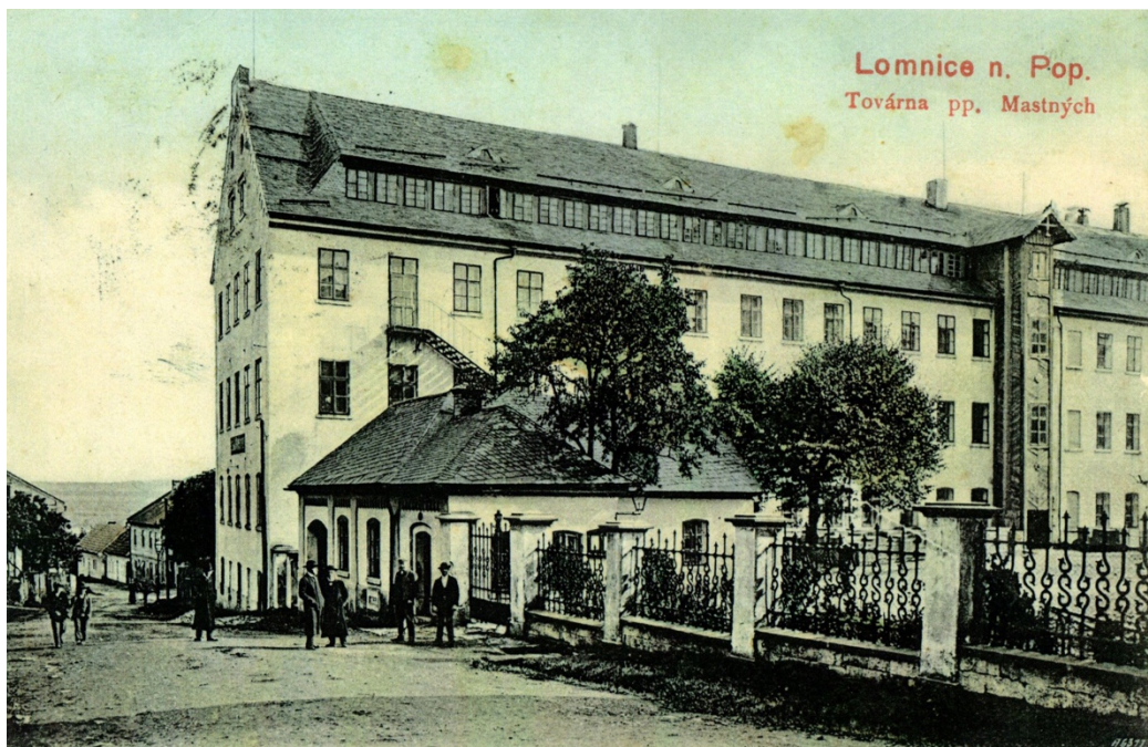
Obrázek 22: Západní pohled na budovu č. p. 211, na jejímž místě v současné době stojí novostavba (Zdroj: Soukromý archiv Dany Grabcové, Pavla Doležala a Jaroslava Kordíka)
