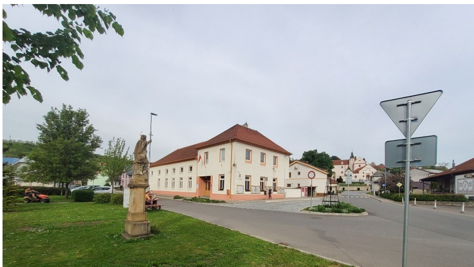
Obr. 36 Budova č. p. 105, bývalý klášterní hostinec. Zdroj: vlastní
