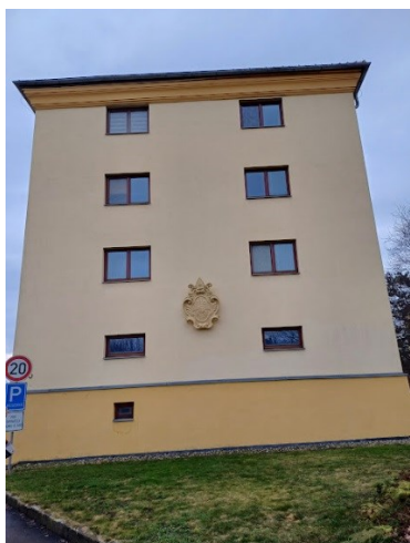
Obr. 33 Cisterciácká sýpka Polešovice, dnes přestavěná na obytný dům. Zdroj: vlastní
