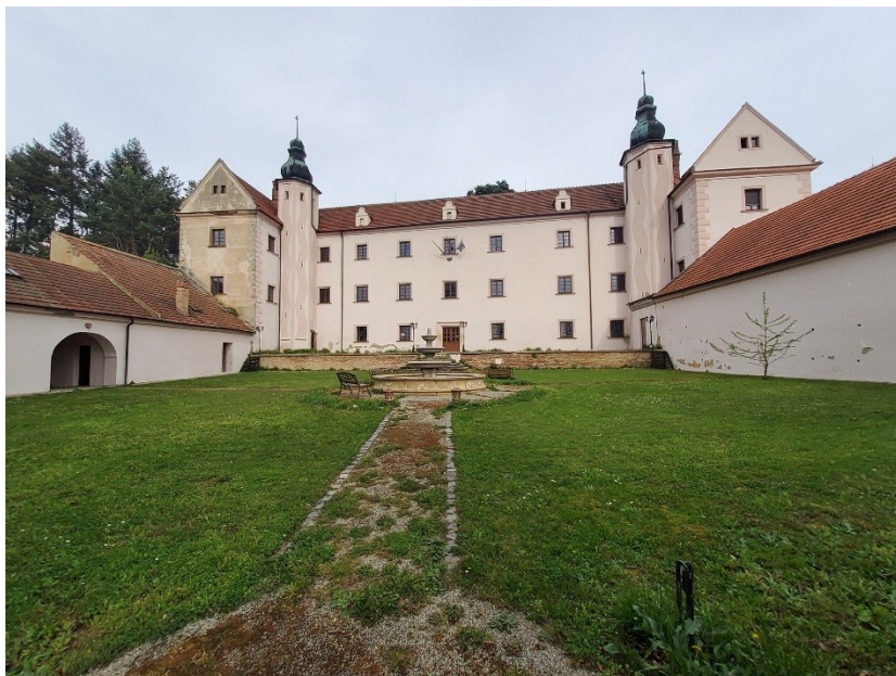
Obr. 35 Zámek Ořechov. Zdroj: vlastní
