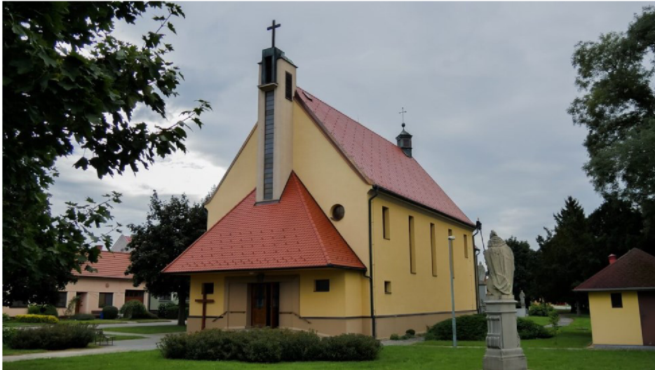
Obr. 46 Kostel Sv. Floriána Nedakonice, postaven na místě bývalých mlýnů. Zdroj: peluchastrechy.cz
