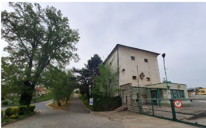
Obr. 34 Bývalý klášterní dvůr v Polešovicích, dnes ZEAS Polešovice, a. s. Zdroj: vlastní
