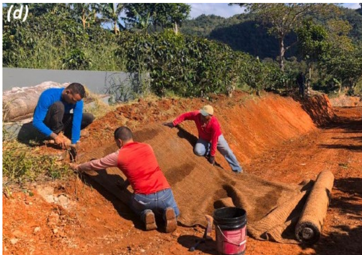
Obrázek 11 – Pokládka kokosové rohože na svah (Ramos-Scharrón et al., 2022)
