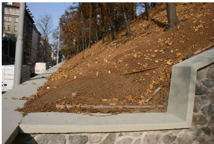
Obrázek 9 – Kokosová geotextílie o plošné hmotnosti 700 g/m 2 v městském parku u pozemní komunikace v Brně (JUTA, 2022)
