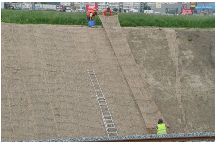
Obrázek 5 – Pokládka jutové geotextílie o plošné hmotnosti 500 g/m 2 u zářezového svahu železničního koridoru ve městě Tábor (JUTA, 2022)
