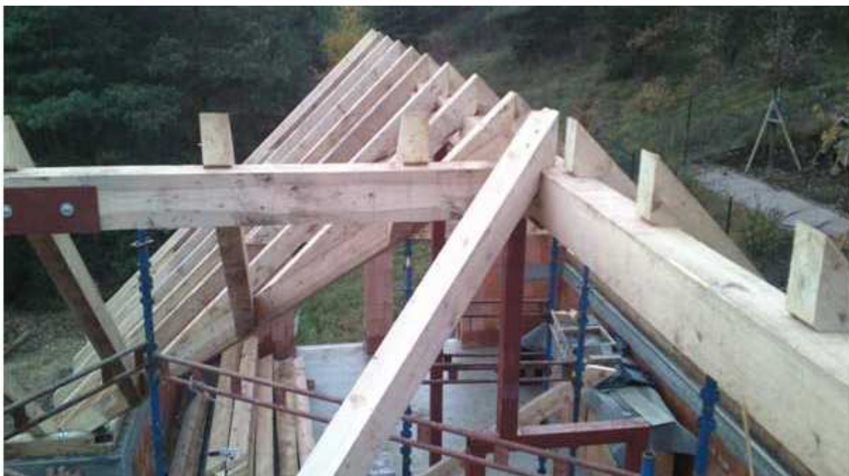
Obrázek 53 Strojně opracovaný krov 7,5m 3
