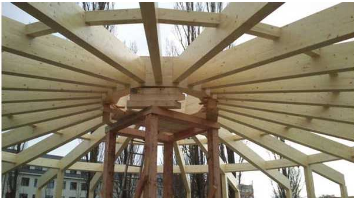
Obrázek 56 Spojení prstence s nárožnicemi
