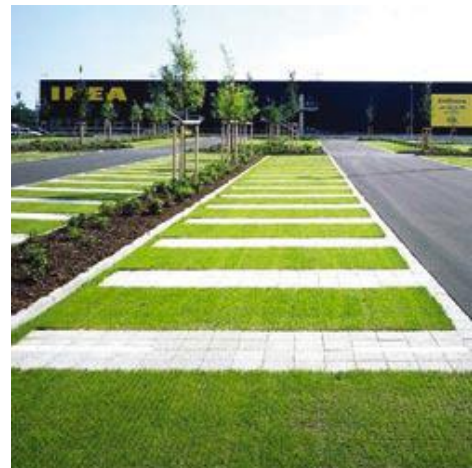
Obrázek 9: Zatravněvací dlaždice použité na parkovacích plochách (Přírodě blízké odvodnění dopravních ploch v sídlech)
