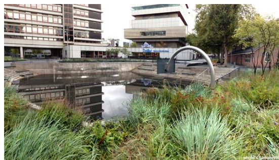
Obrázek 15: Náměstí Benthemplein v Rotterdamu, největší ze tří nádrží plně naplněná srážkovou vodou. (DEUrbanisten)
