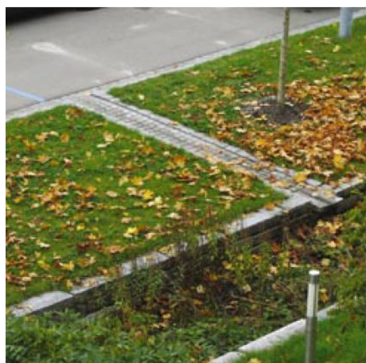
Obrázek 13: Dlážděné žlaby svádějí vodu ze silnice do vsakovacích rýh (Přírodě blízké odvodnění dopravních ploch v sídlech)
