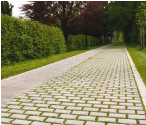
Obrázek 10: Polopropustná dlažba použitá v praxi (Přírodě blízké odvodnění dopravních ploch v sídlech)
