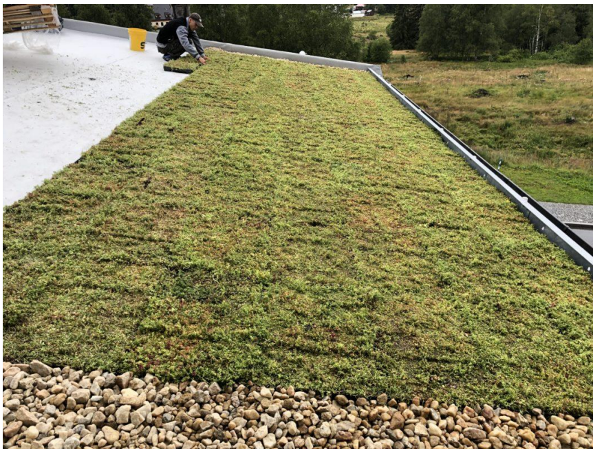
Obrázek 6: Extenzivní vegetační střecha (ECOSSEDUM)
