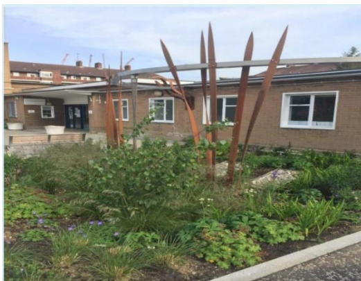
Obrázek 19: Dešťová zahrada před mateřskou školkou přivod vody ze střech. (susDrain)
