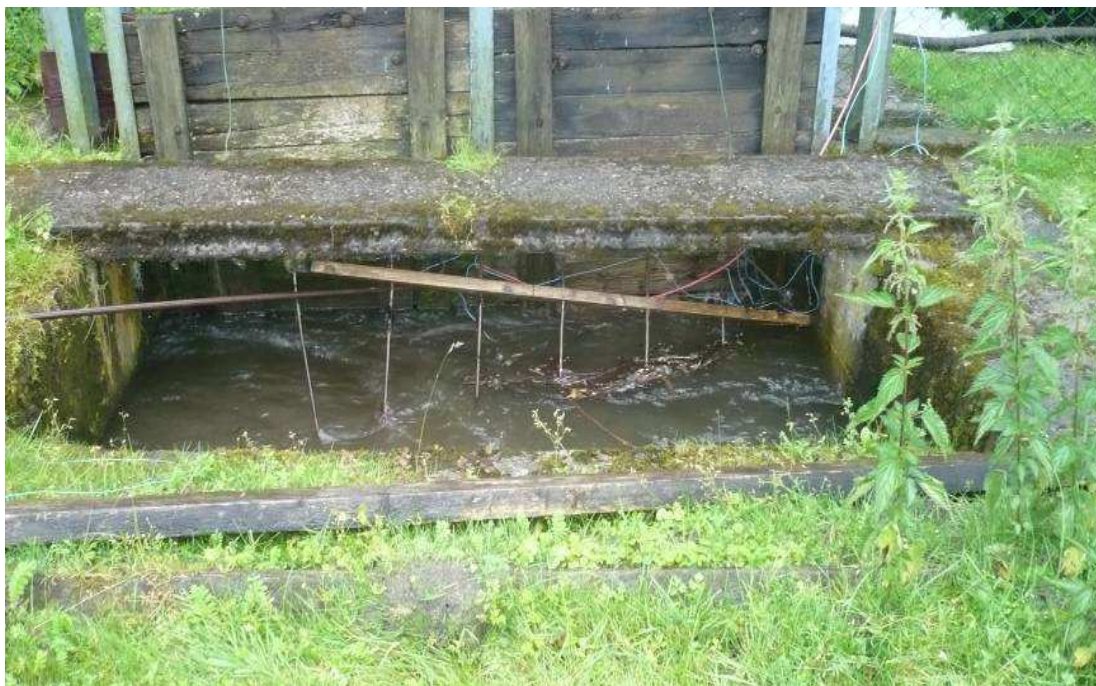
Obrázek 18. Zařízení nainstalované v přítokovém kanále.
