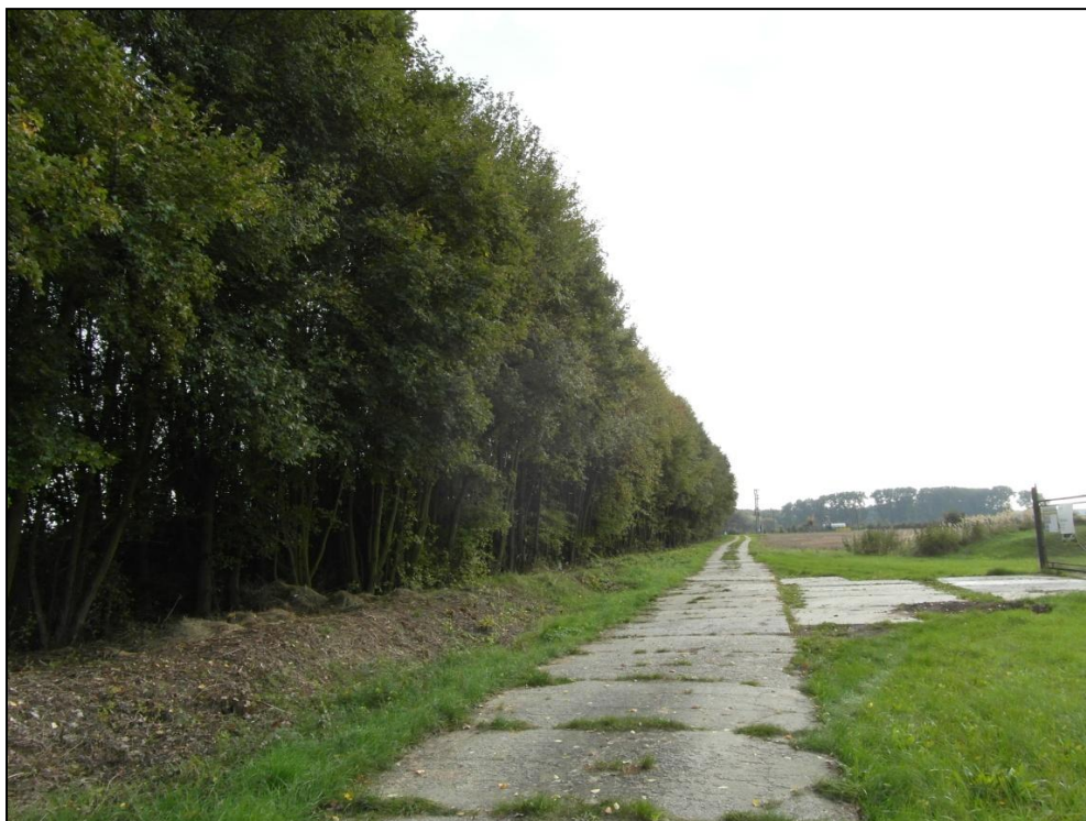
Obr. 7 Betonová cesta podél TVP 2 (29. 9. 2013).
