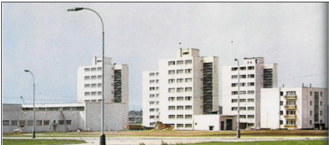
Praha-Libuš. Učňovské internáty, svobodárna a pohotovostní byty.
