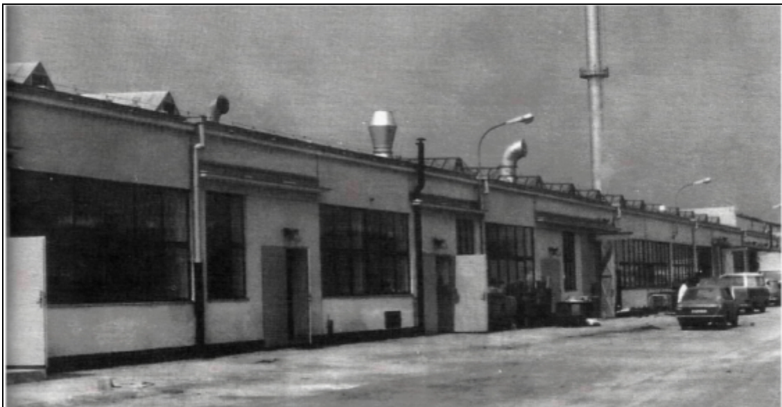
Masokombinát Praha-Jih. Údržbářské dílny.
