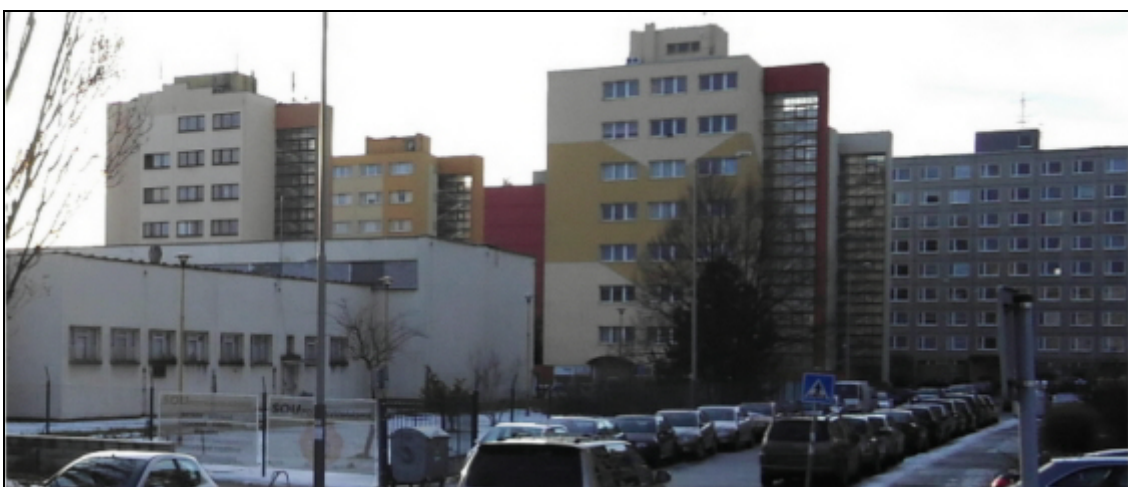
Praha-Libuš. Výškové panelové domy, které jsou zprivatizované do osobního vlastnictví.
