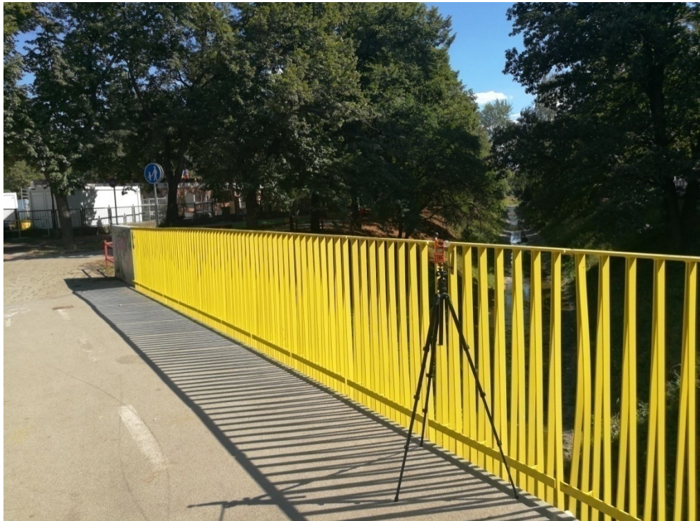
Obr. 2: Stanoviště č. 1 a 9 (Makuchova lávka).
