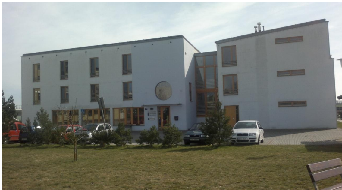
Obrázek 4 Budova Domu sv. Františka
