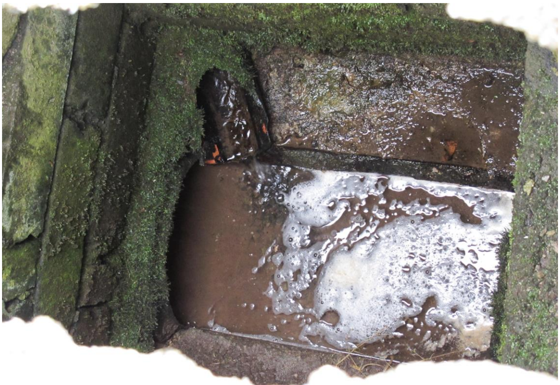
Příloha č.5: Fotografie – Stávající soutoková a revizní šachta pod uzávěrovým profilem vybraného sub-povodí (datum pořízení: květen 2018)
