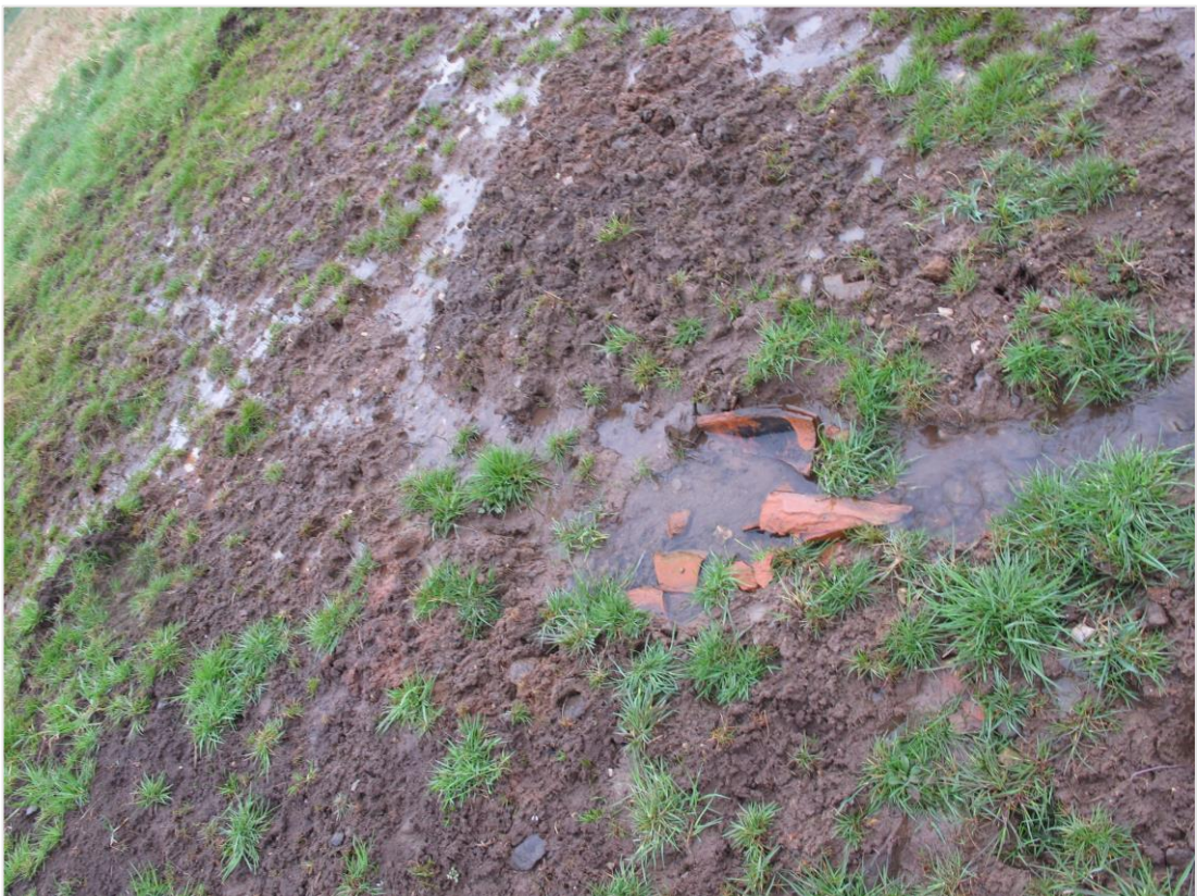
Příloha č.4: Fotografie – Trvale zamokřená oblast s detailem porušeného POZ (datum pořízení – květen 2018)
