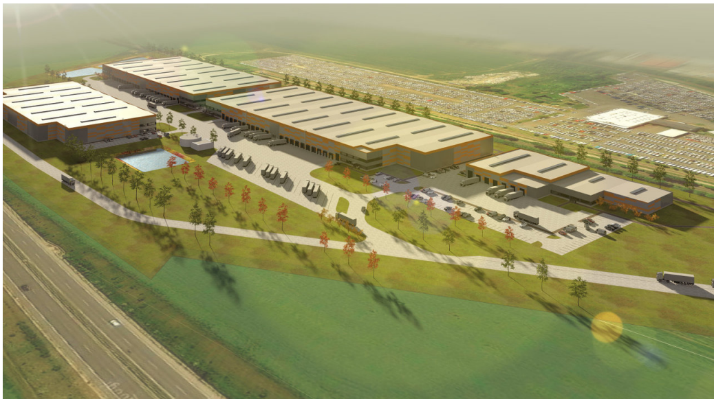
Obr. 2.2 Letecký pohled na distribuční sklad
