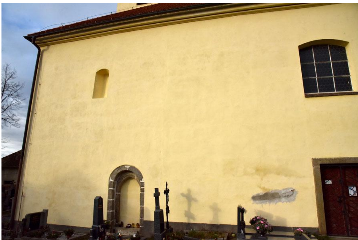
Obr. 89 Jižní stěna lodi se zalděnými otvory - Nesvačily.
