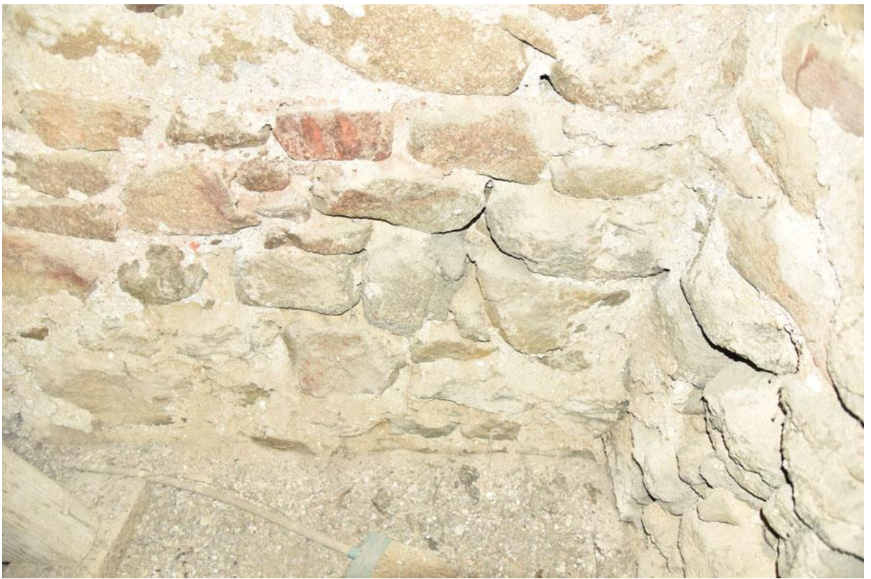
Obr. 20 Kvádříkové zdivo věže - Olbramovice.
