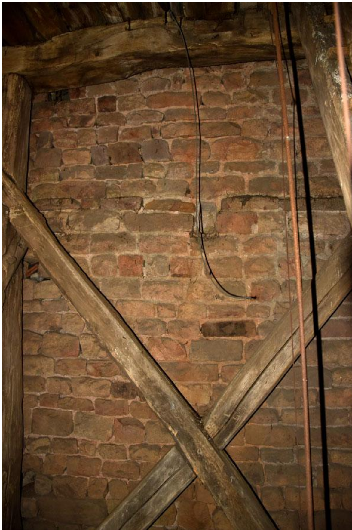
Obr. 44 Kvádříkové zdivo věže - Ouběnice.
