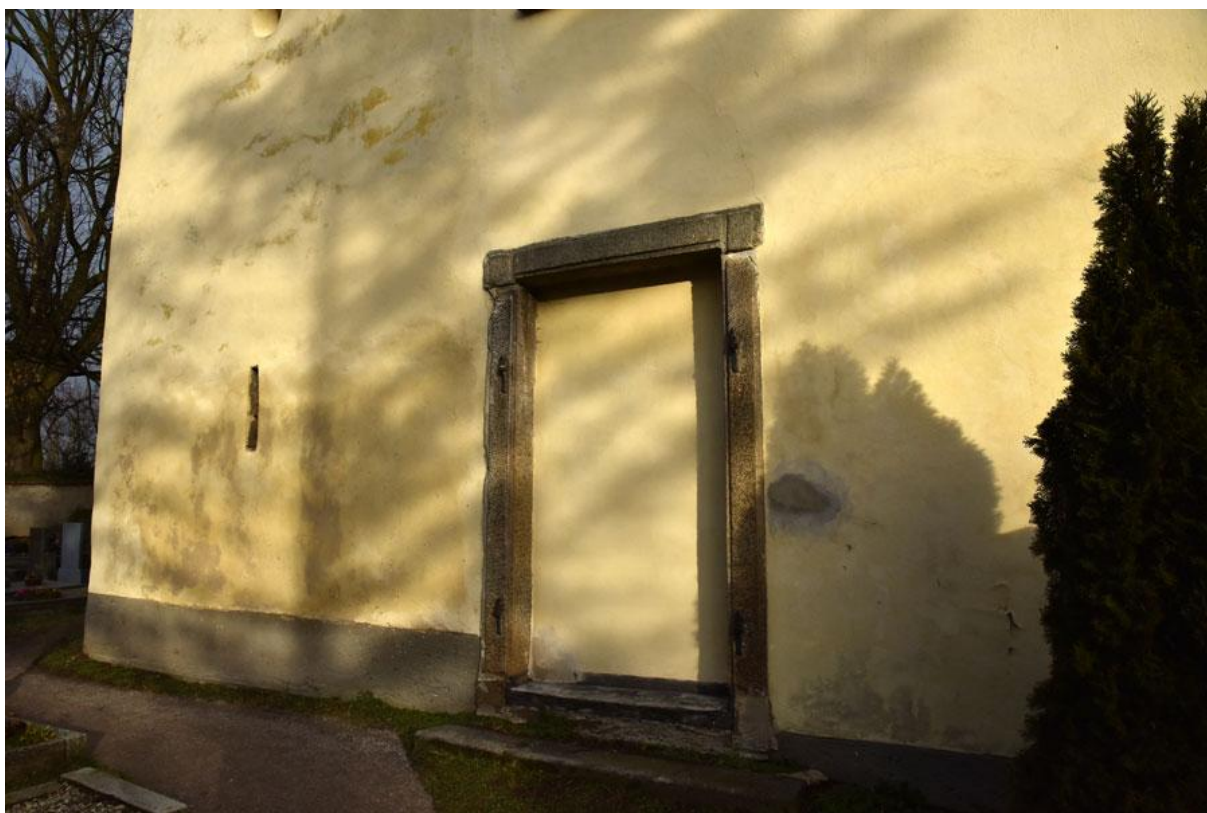
Obr. 94 Zazděný portál v průčelí - Nesvačily.
