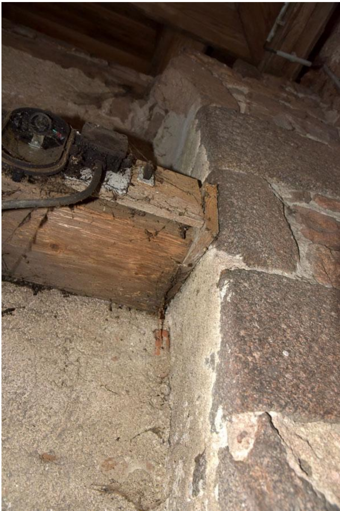
Obr. 48 Zbýlý fragment po vybouraných sdužených oknech - Ouběnice.
