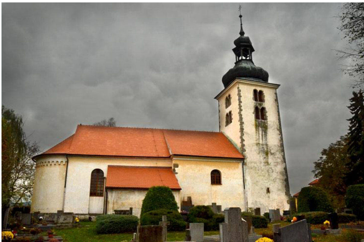
Obr. 7 Pohled na severní část kostela - Olbramovice.
