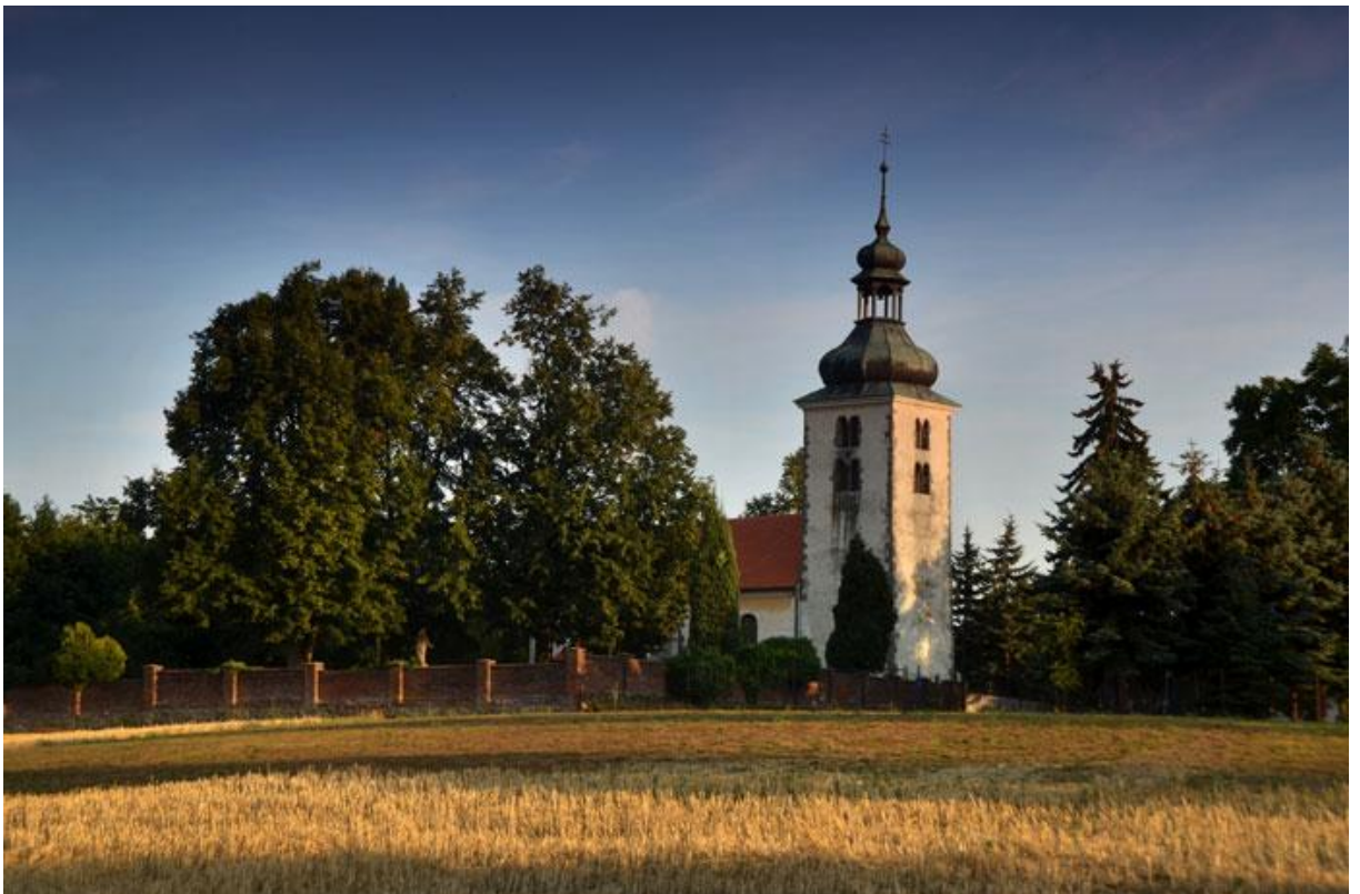
Obr. 2 Kostel Věch svatých - pohled při příjezdu do obce ze severu - Olbramovice.
