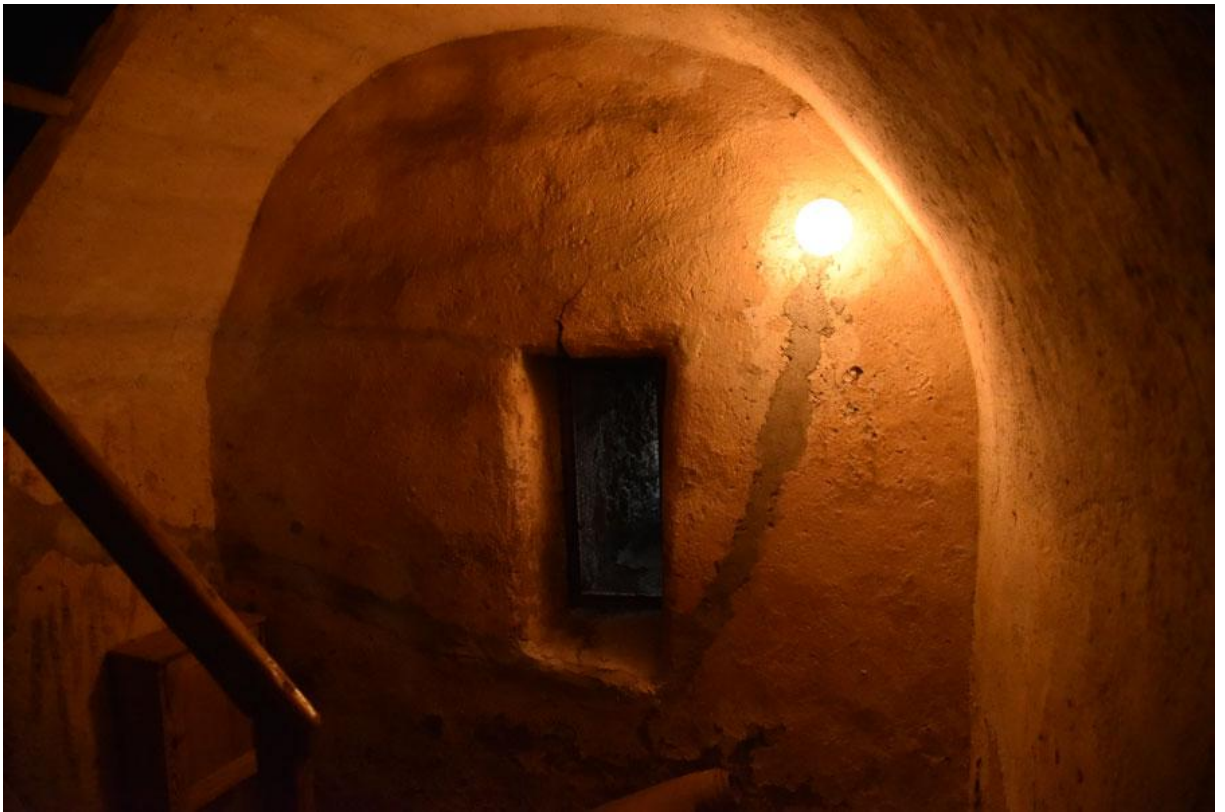
Obr. 19 Zaklenutí přízemního prostoru věže - Olbramovice.
