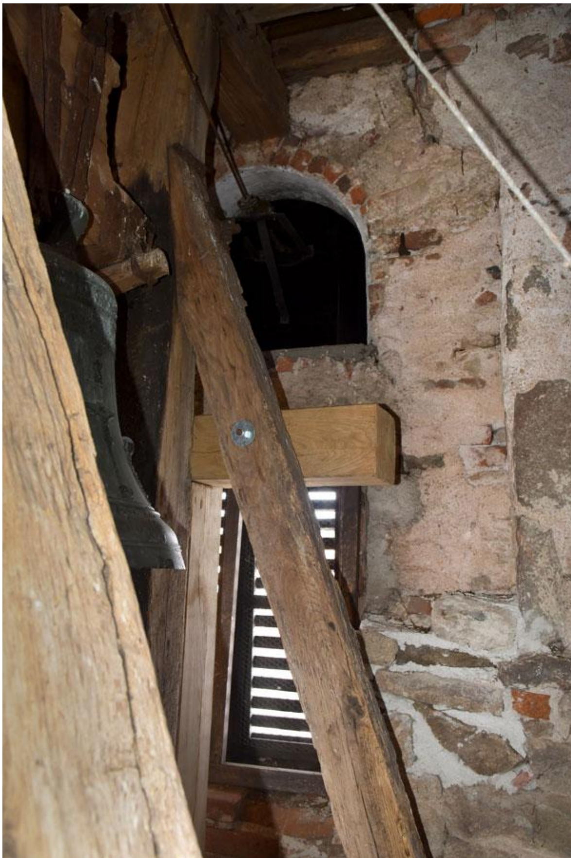
Obr. 47 Novější okenní otvor - severní část věže - Ouběnice.
