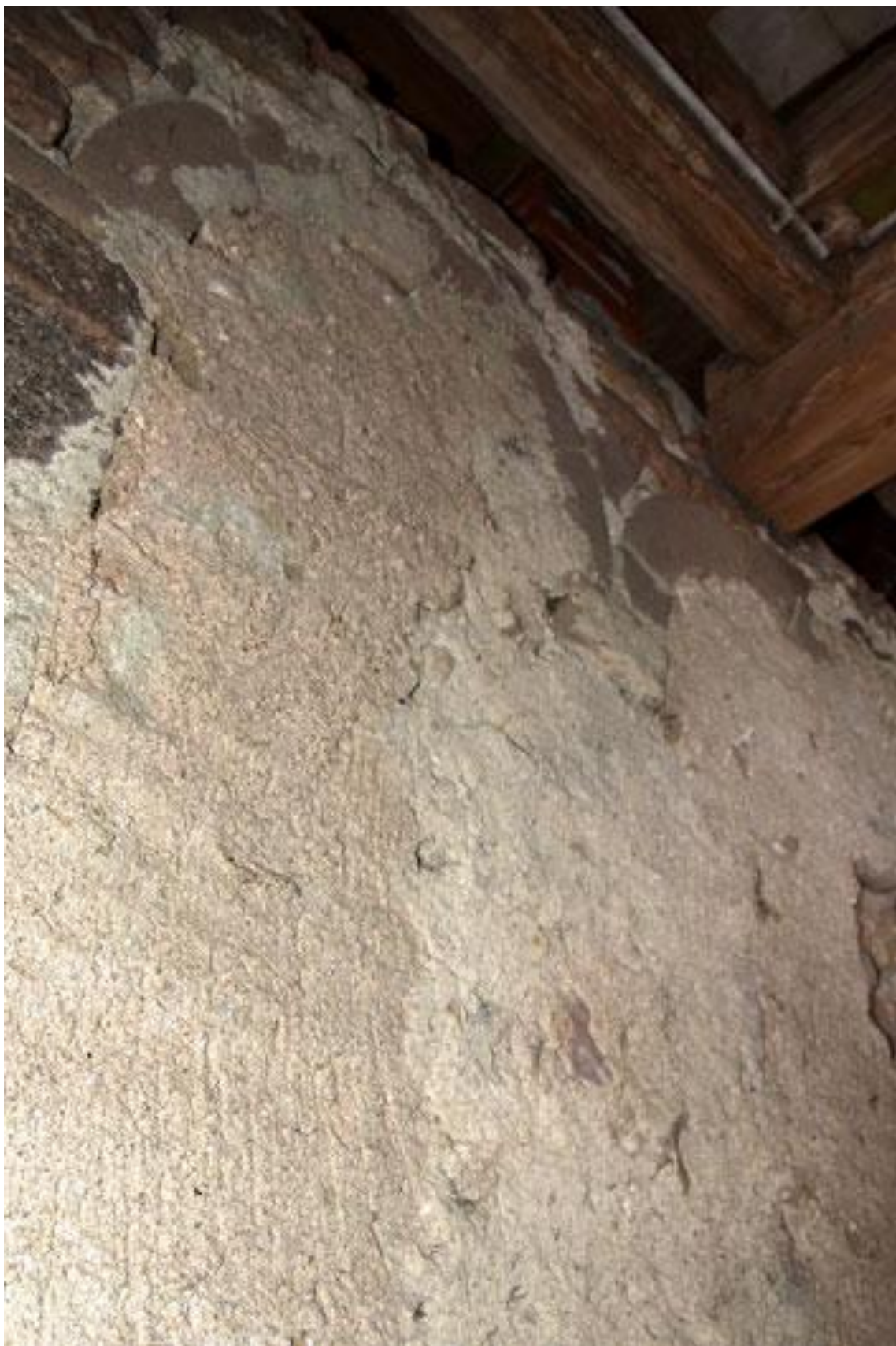
Obr. 50 Zazděná sdružená okna na východní stěně věže - Ouběnice.
