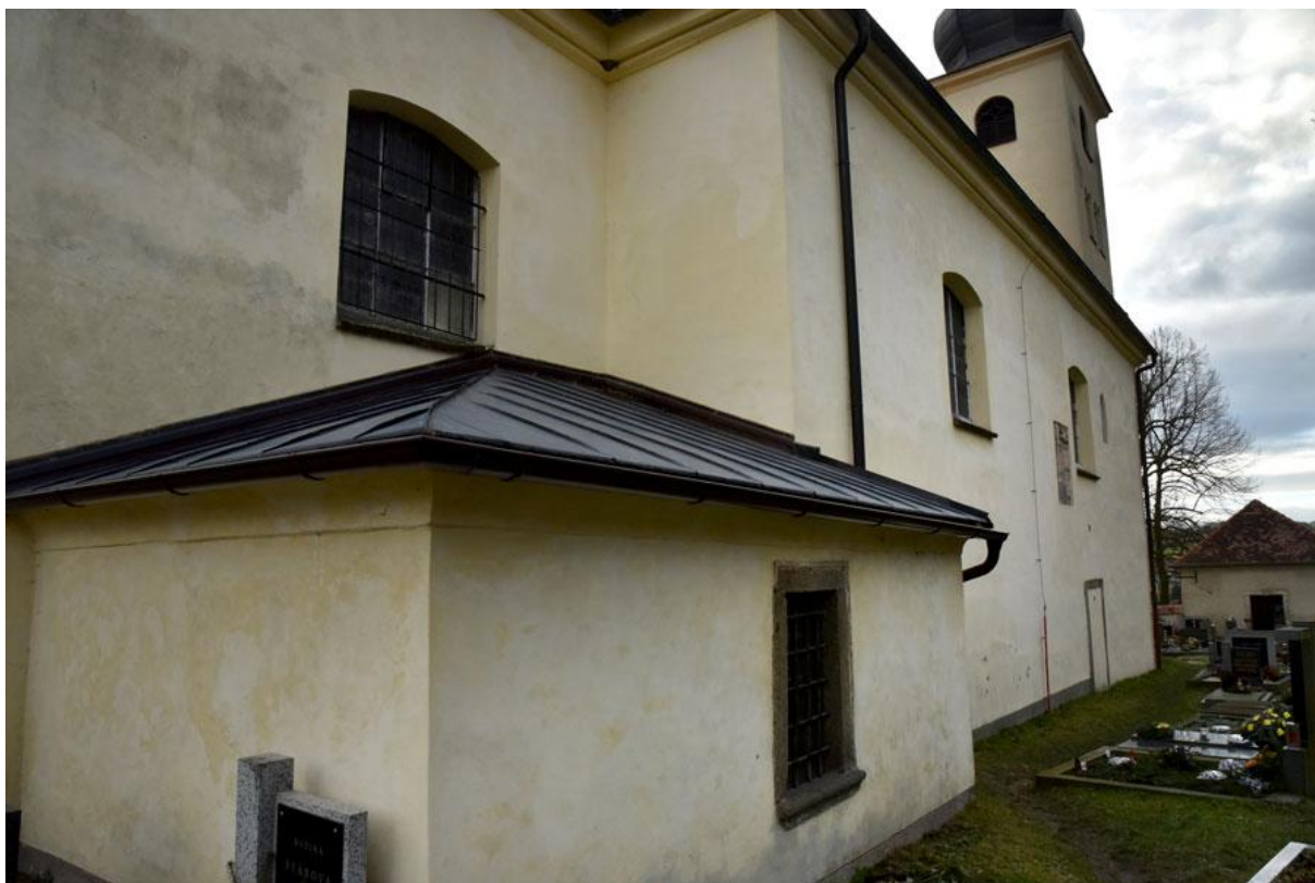
Obr. 96 Severní část kostela se sakristií - Nesvačily.
