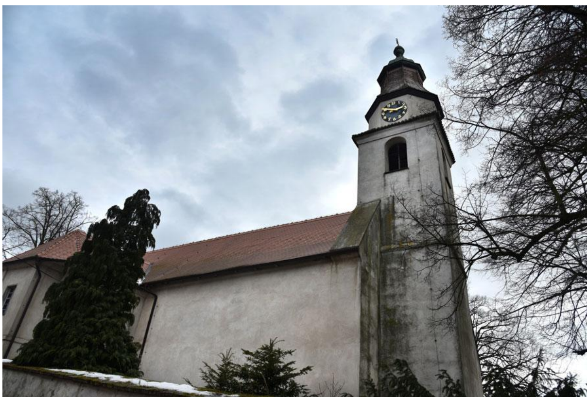
Obr. 77 Severní stěna lodi s věží - Jankov.
