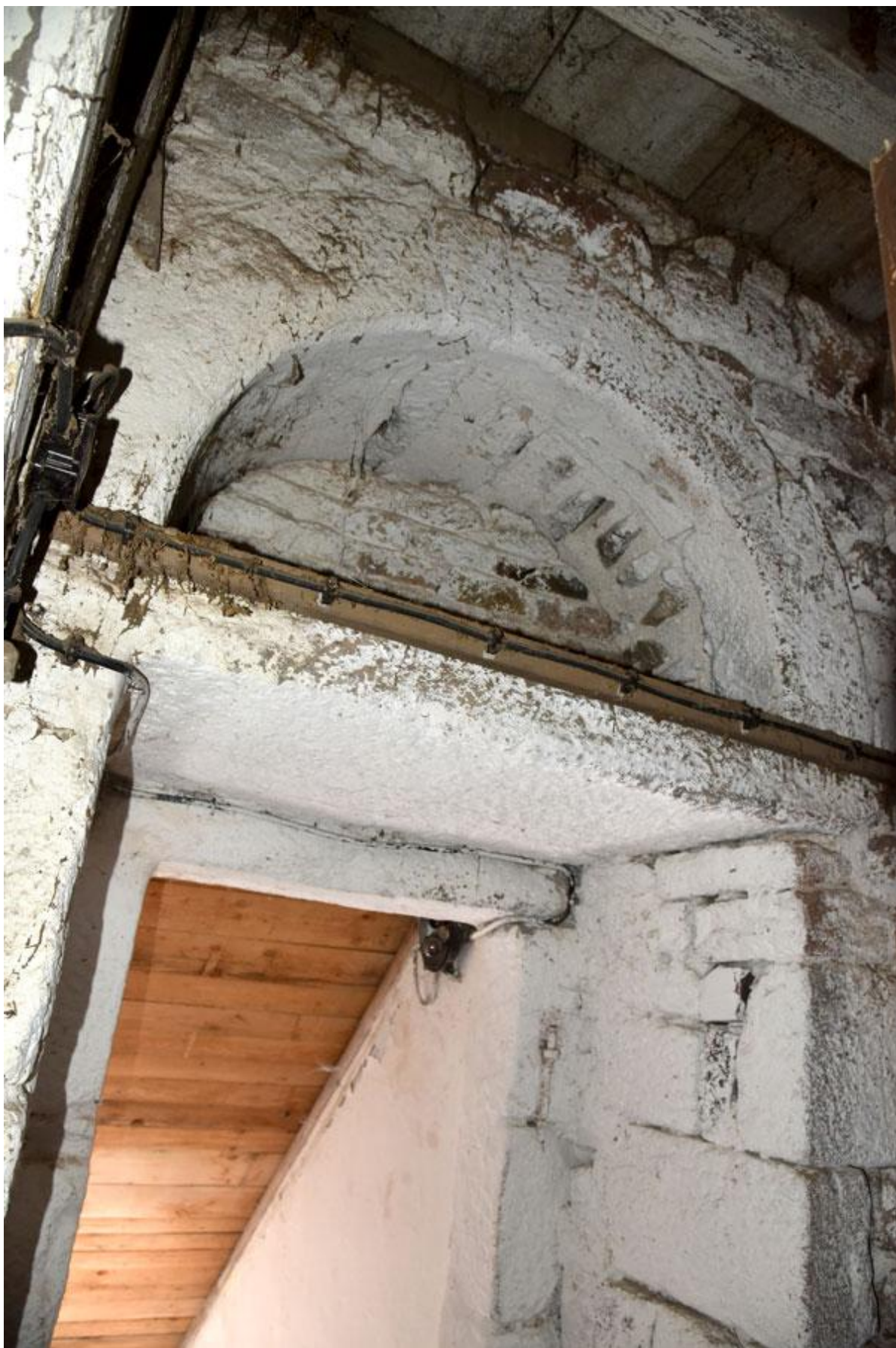
Obr. 46 Detail portálu v jižní stěně u věže - Ouběnice.
