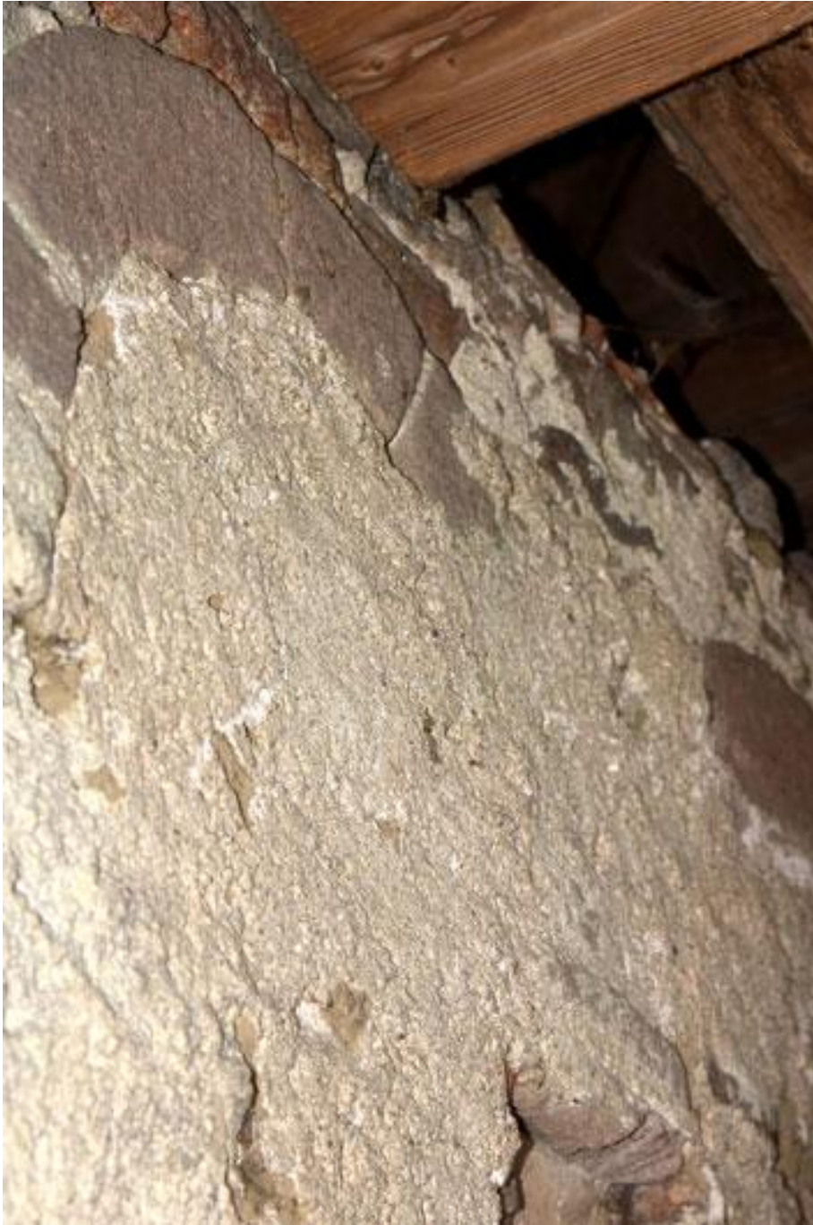
Obr. 49 Zazděná sdružená okna na východní stěně věže - Ouběnice.
