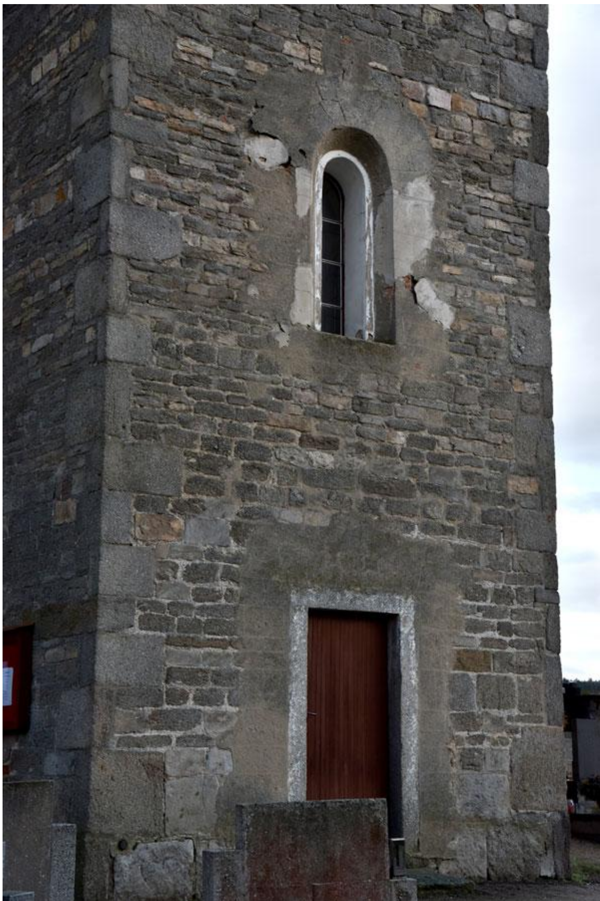
Obr. 57 Detail věže - upravené otvory - V. Janovice.
