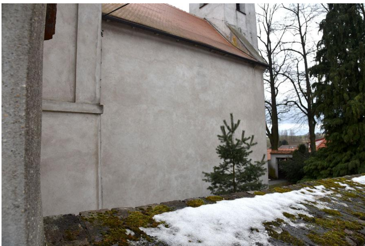
Obr. 81 Severní stěna lodi - Jankov.
