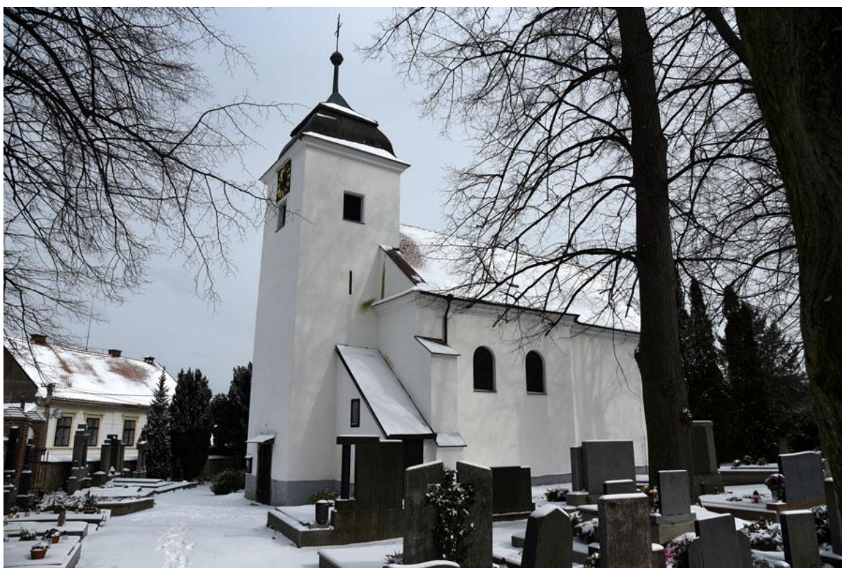
Obr. 37 Kostel sv. Markéty, pohled na jižní část - Ouběnice.
