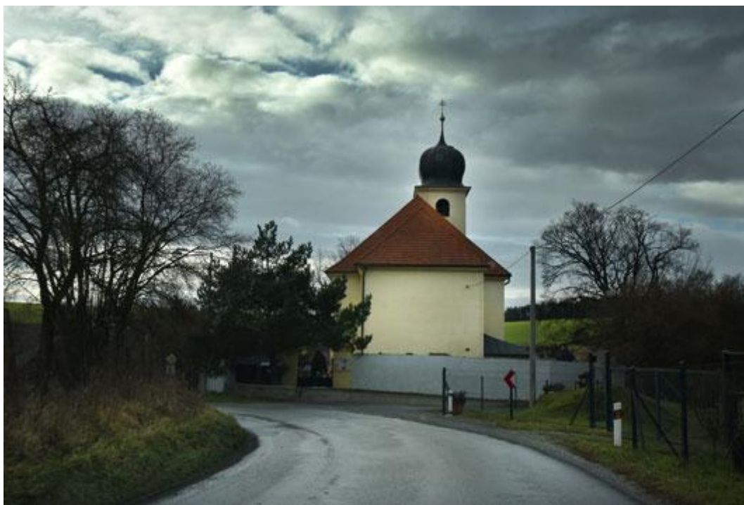
Obr. 85 Kostel Nalezení sv. Kříže - pohled z jihu - Nesvačily.
