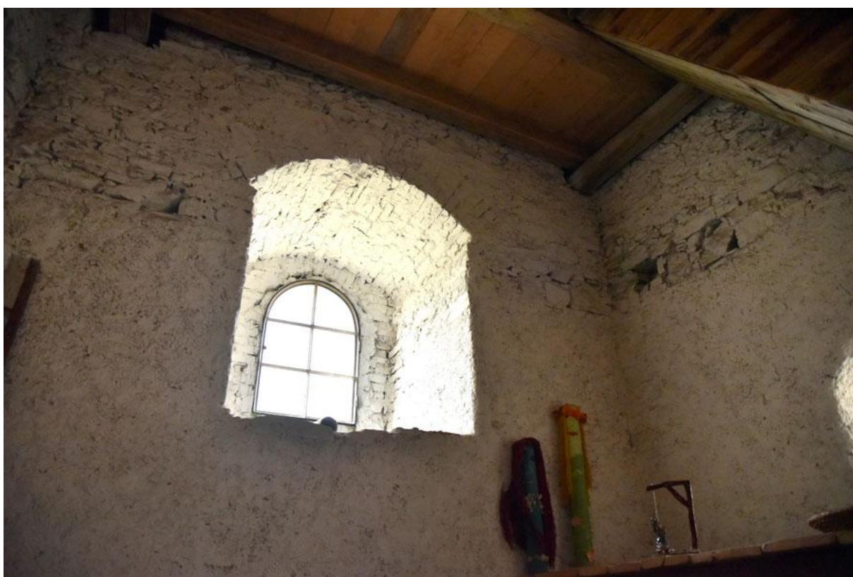
Obr. 108 Upravené okno v prvním patře věže - Votice.
