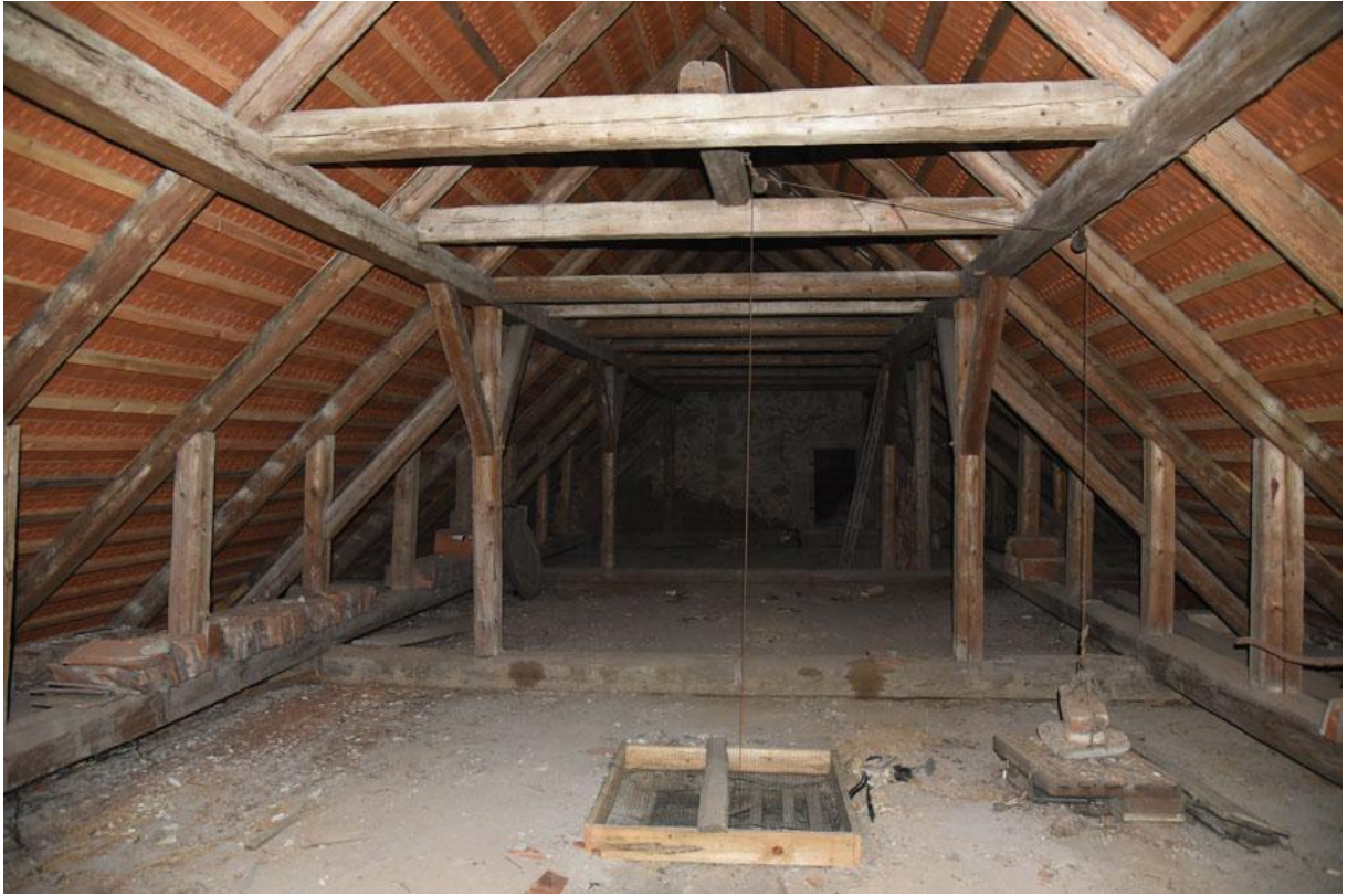
Obr. 17 Krov - pohled směrem k věži - Olbramovice.
