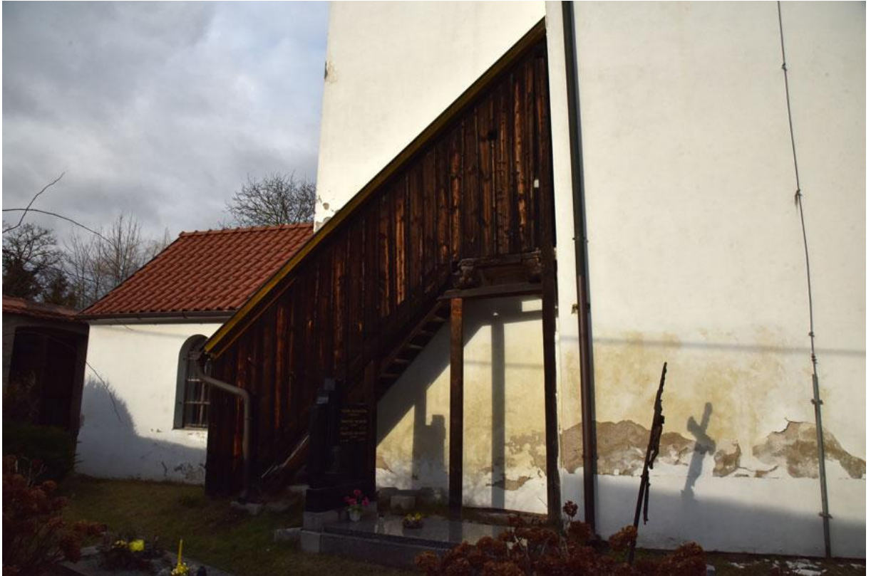
Obr. 30 Schodiště na kruchtu - Tožice.
