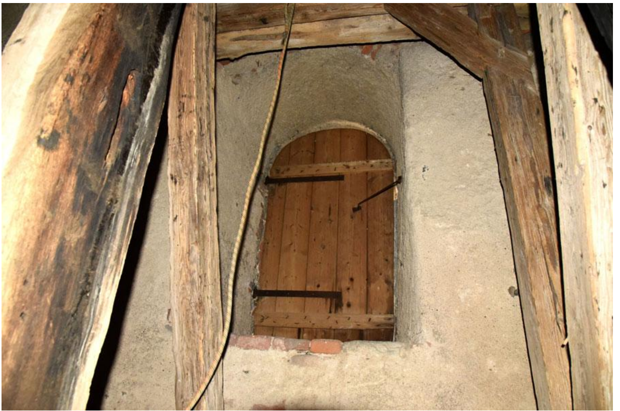
Obr. 35 Okenní otvor - Tožice.
