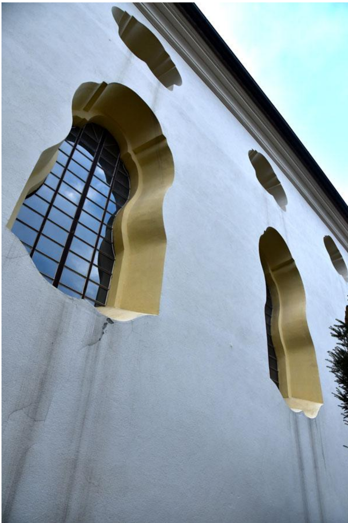
Obr. 104 Kasulová okna na jižní straně lodi - Votice.
