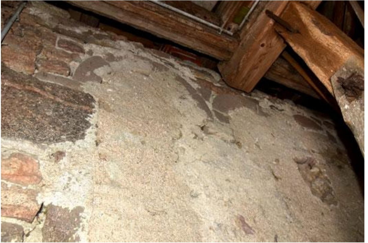
Obr. 51 Zazděná sdružená okna na východní stěně věže - Ouběnice.
