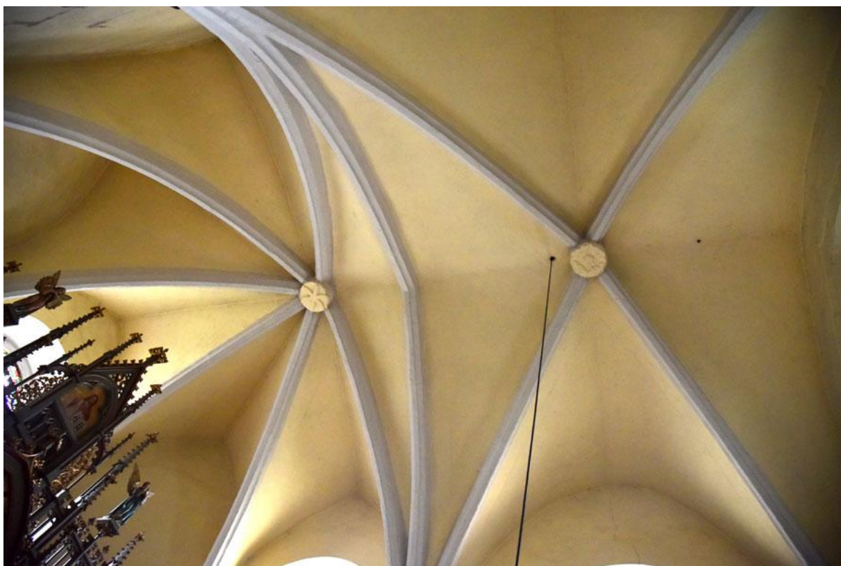
Obr. 67 Žebrová klenba presbytáře – V. Janovice.
