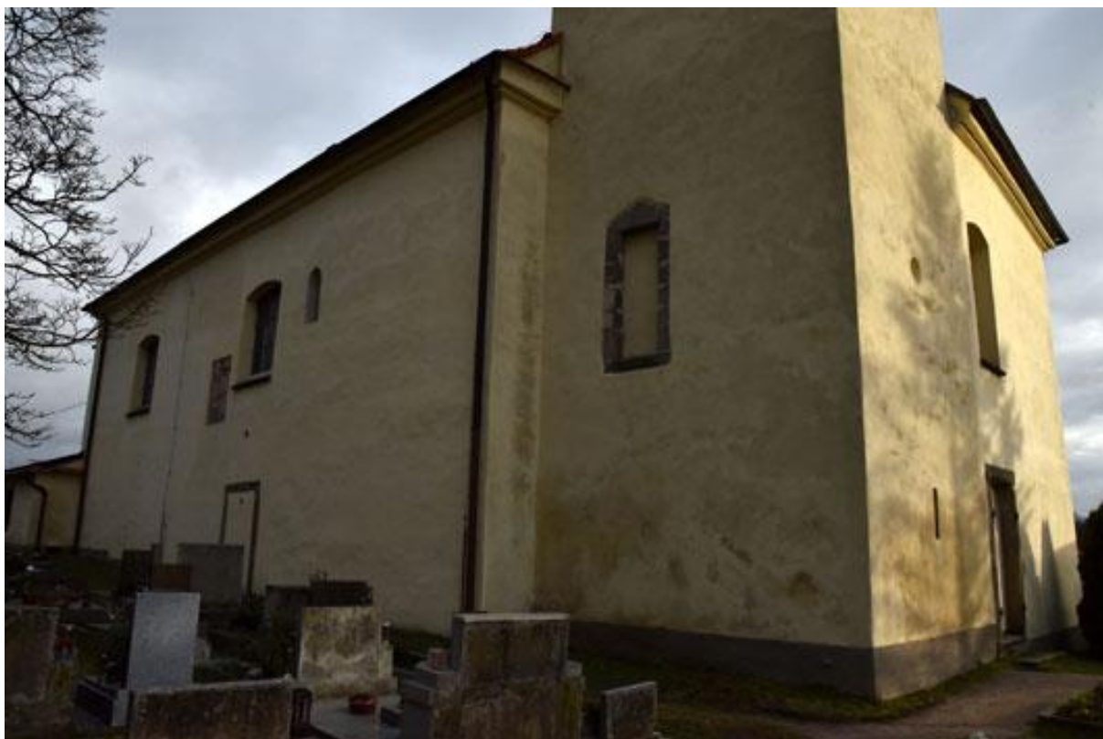
Obr. 93 Severní stěna lodi a věže - Nesvačily.
