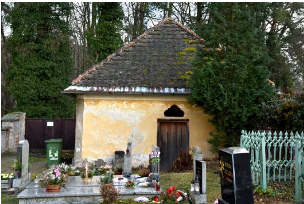
Obr. 60 Bývalá márnice v jihovýchodním rohu obvodní zdi – V. Janovice.
