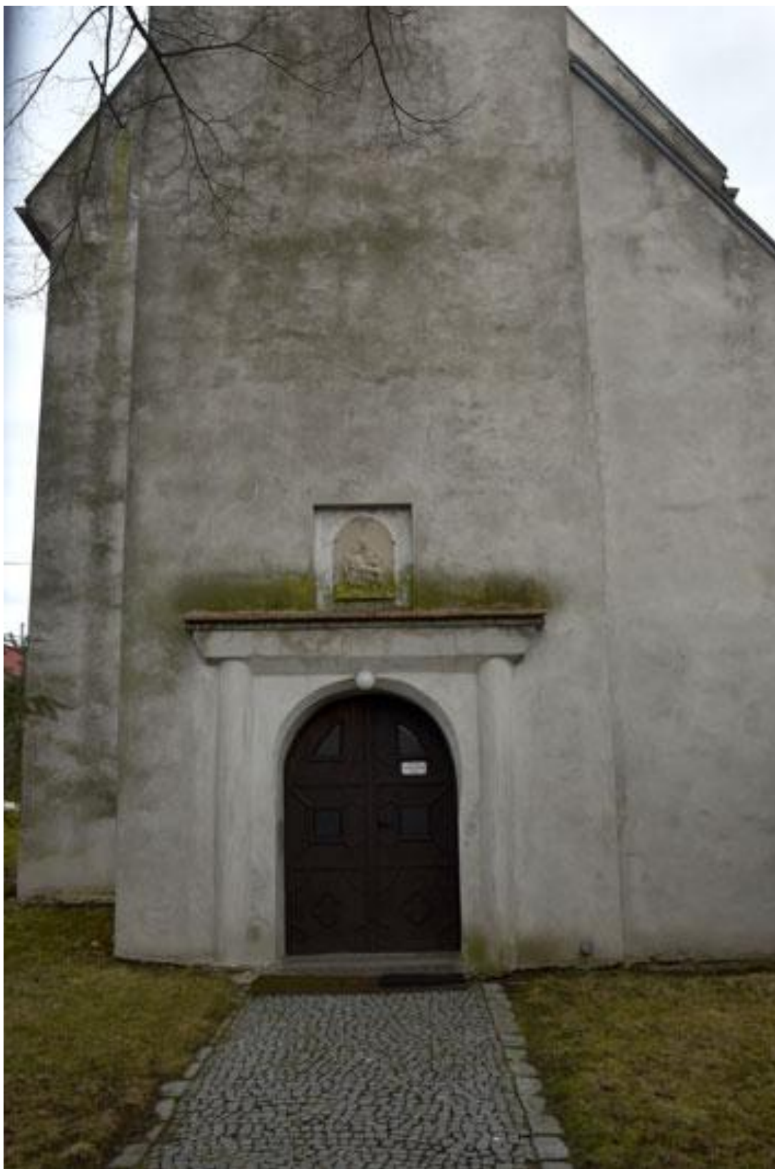
Obr. 84 Vstup skrz věž - Jankov.
