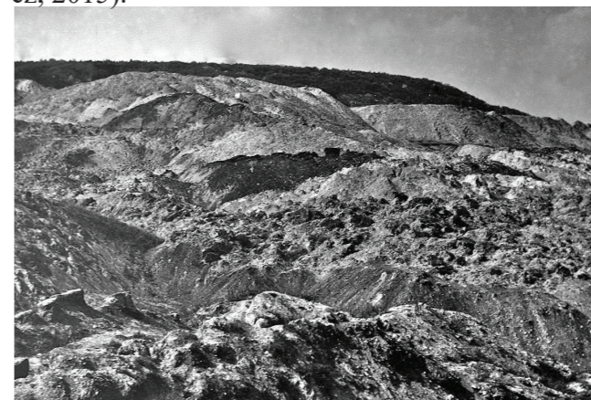
Obr.č. 9: Výsypka lomu Slatinice - stav před rekultivací
