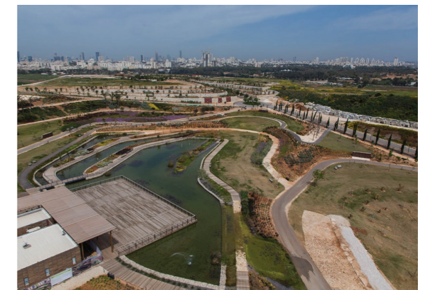
Obr.č. 30: Retenční nádrž
