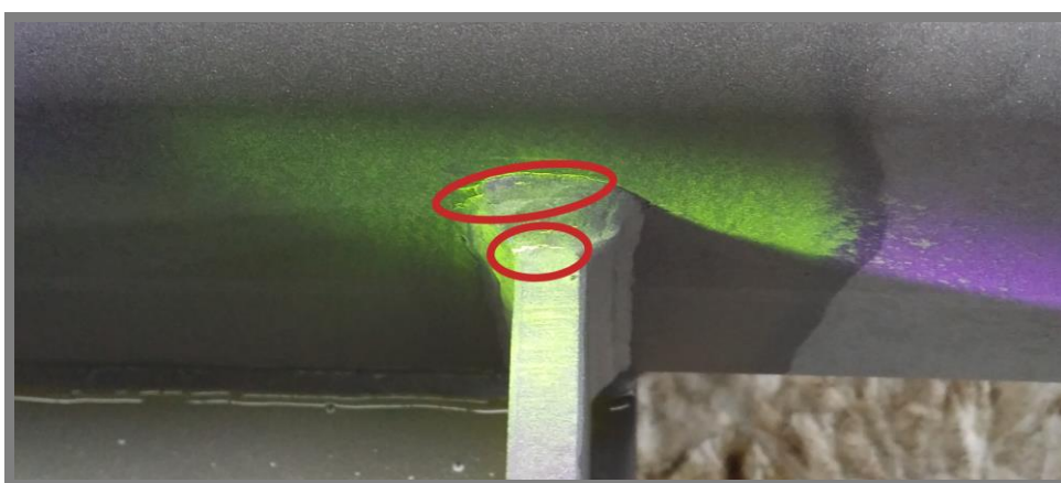
Obr. 2.19 Odhalení trhlin při defektoskopii [1]
