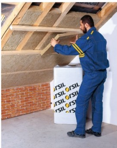
Obrázek [7]: Uložení TI pod krokve
