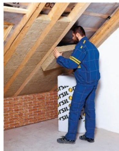
Obrázek [6]: Uložení TI mezi krokve
