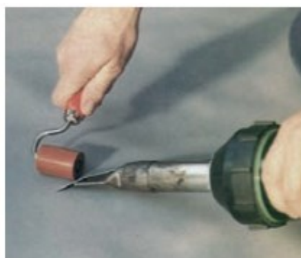
Obrázek [3]: Spojování fólie
