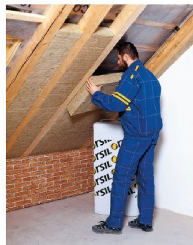
Obrázek [6]: Uložení TI mezi krokve
