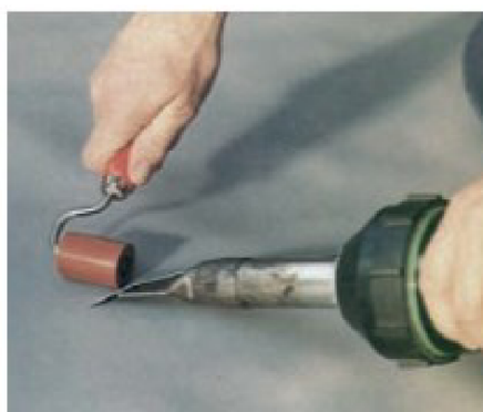
Obrázek [3]: Spojování fólie
