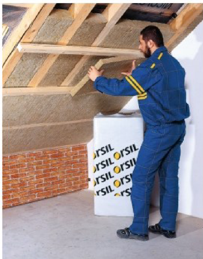
Obrázek [7]: Uložení TI pod krokve
